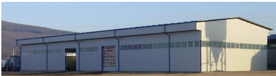
Slika 6: Prikaz zatvorenog skladišta
