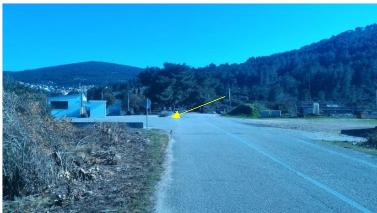
Slika 3.30. Prilaz stanici za tehnički pregled vozila
