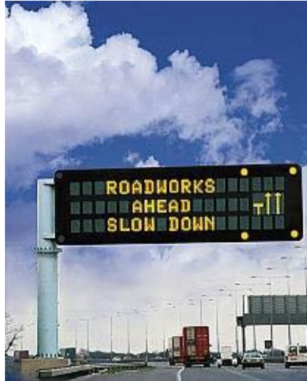
Slika 3. VMS - upozorenje o radovima na cesti, [7]
