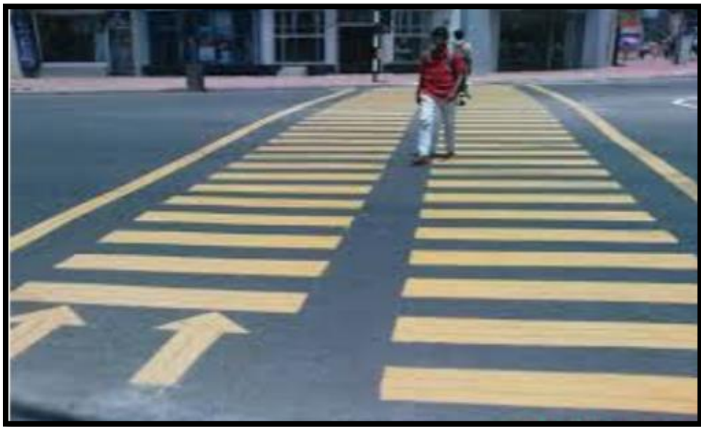
Slika 49 Pješački prijelaz s odvojenim tokovima [16]
