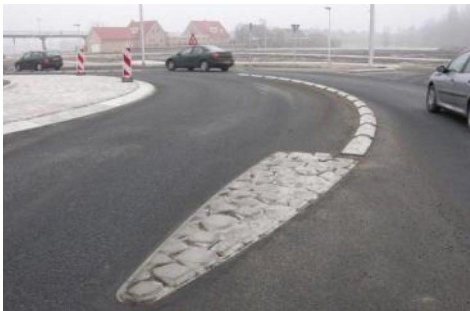
Slika 3.22. Početak montažnog rubnjaka – „špica“ [7]
