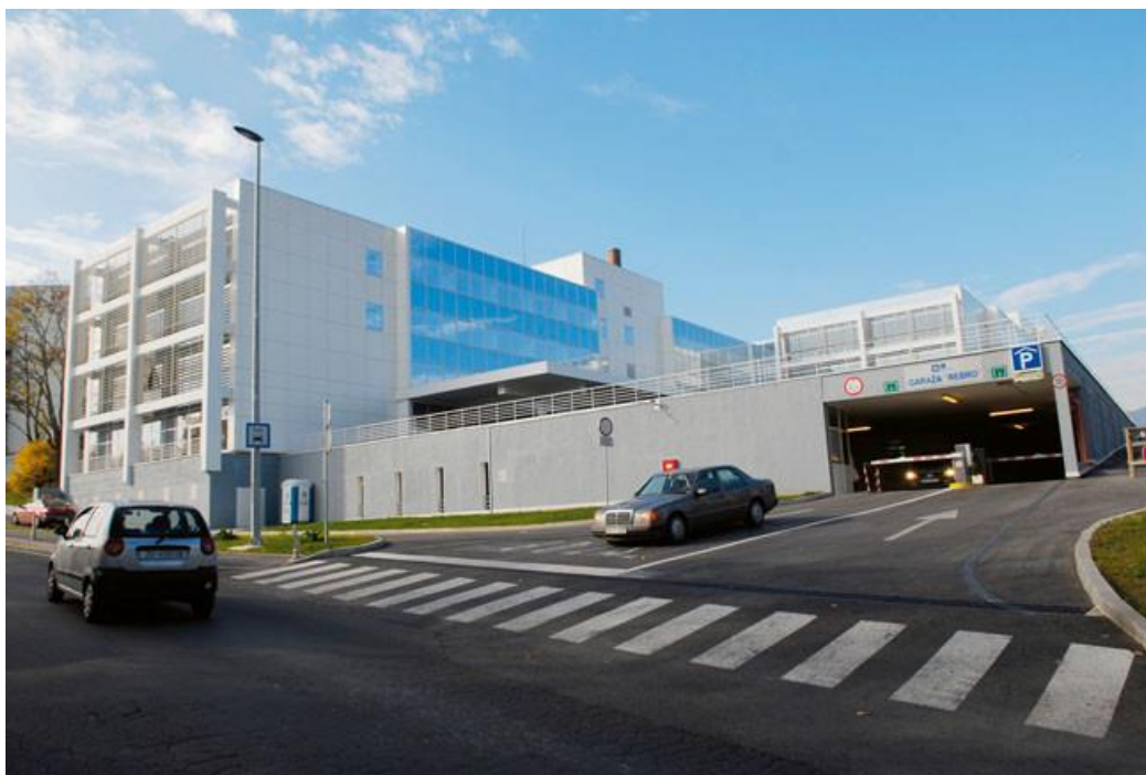
Slika 16. Prikaz ulazno-izlazne rampe garaže Rebro
