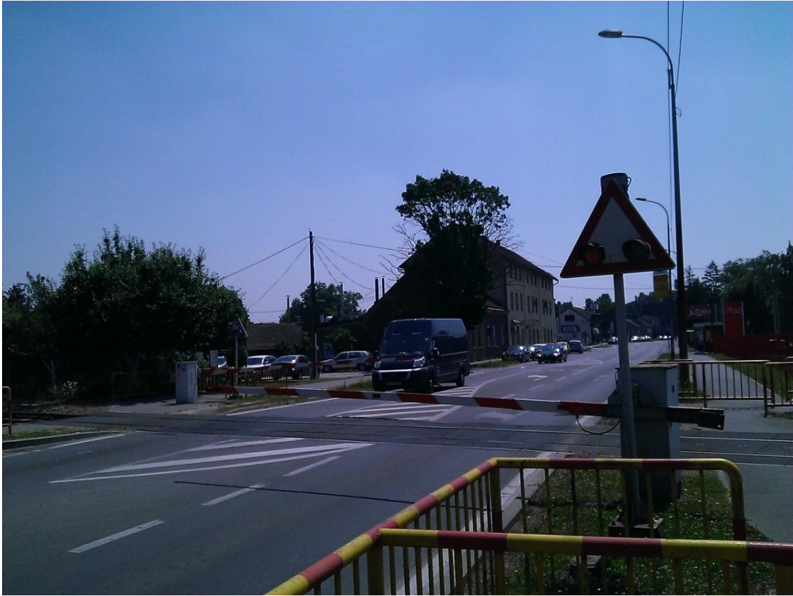
Slika 7. Željezničko-cestovni prijelaz od strane Kloštra
