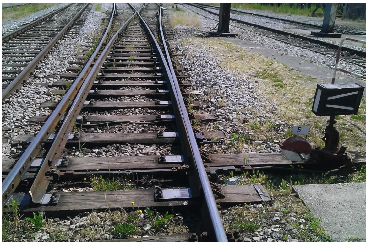
Slika 3. Skretnica u kolodvoru Bjelovar
