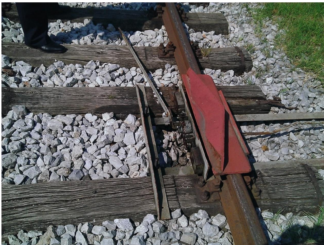
Slika 4. Iskliznica u kolodvoru Bjelovar
