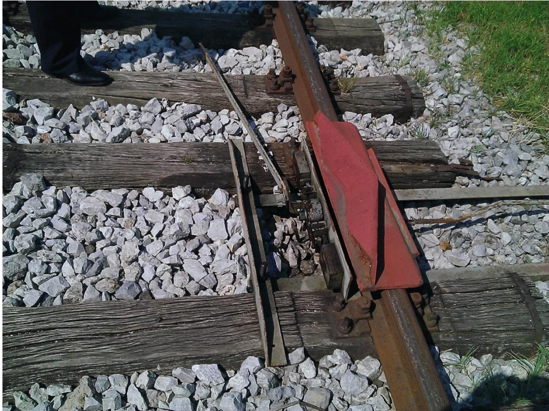
Slika 4. Iskliznica u kolodvoru Bjelovar
