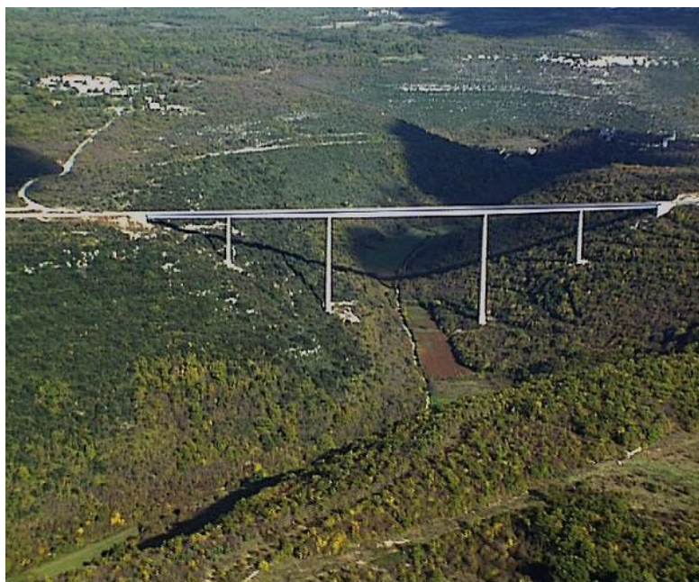
Slika 12. Vijadukt Limska Draga
