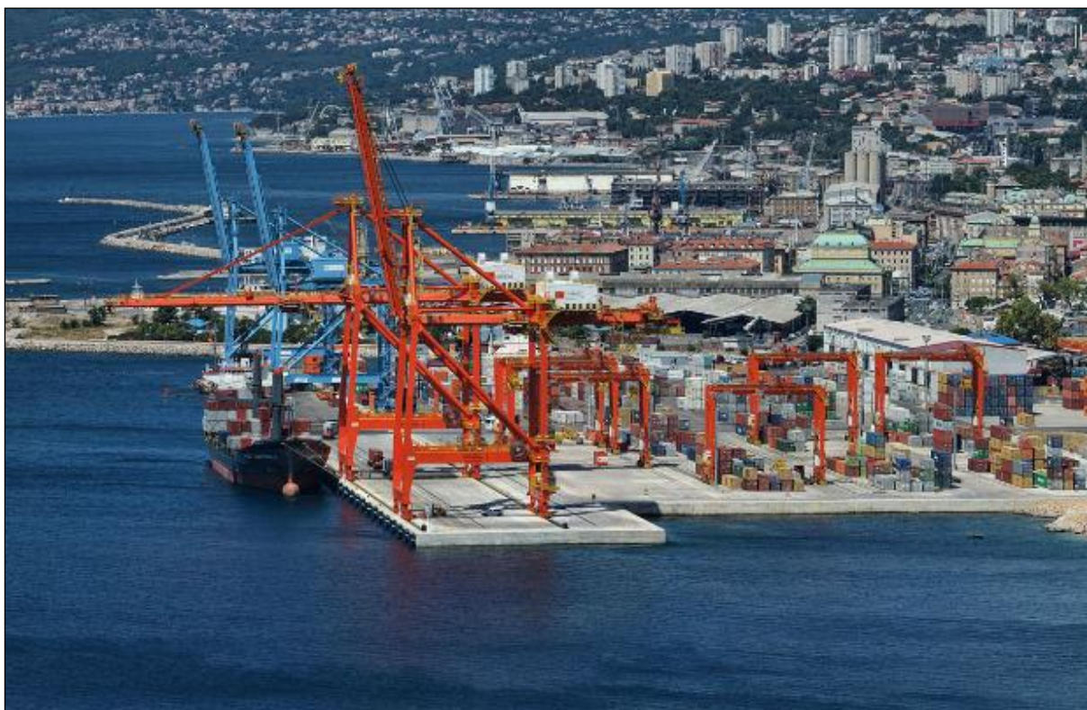
Slika 8. Terminal Rijeka Brajdica
