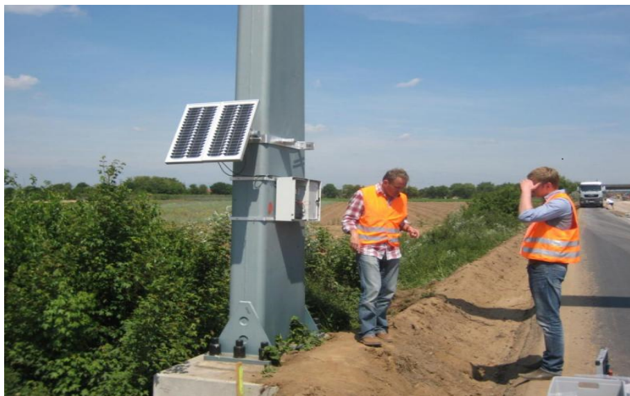
Slika 7. Postavljenje BLIDS senzora [19]
