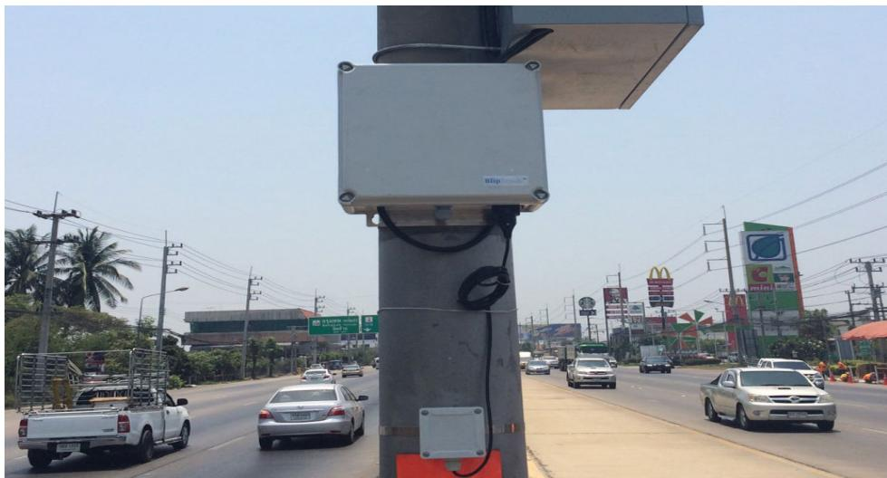
Slika 10. BlipTrack senzor [21]
