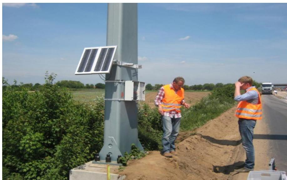
Slika 7. Postavljenje BLIDS senzora [19]
