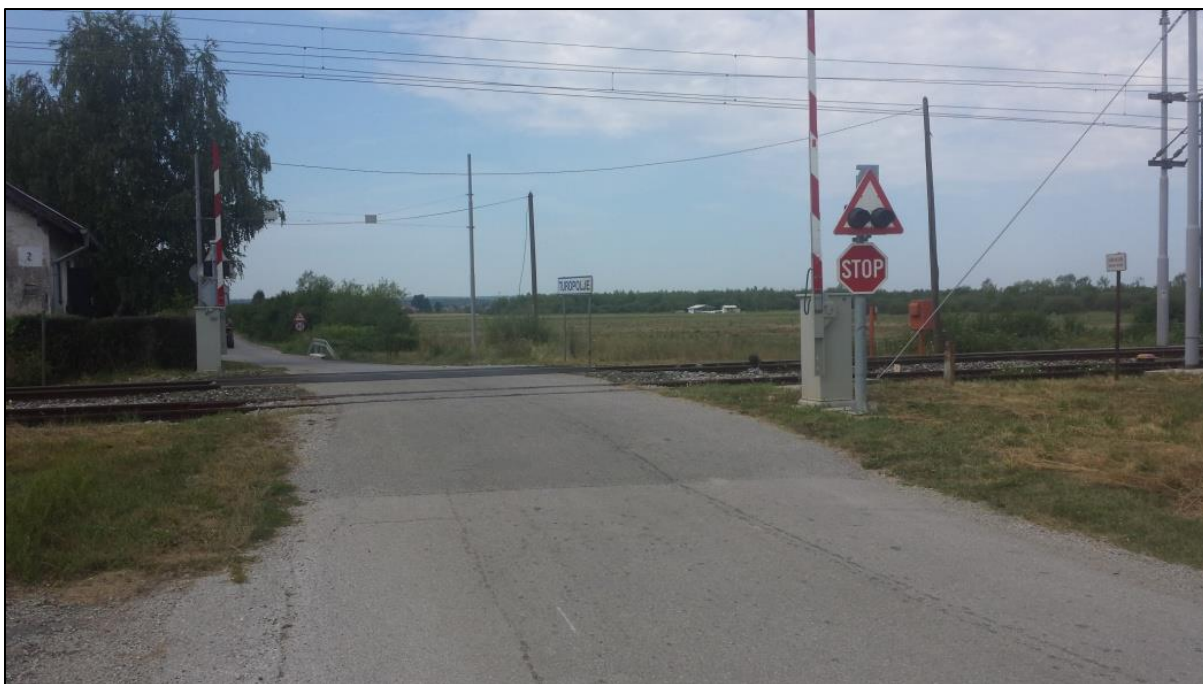
Slika 13. Željezničko-cestovni prijelaz „Turopolje“ iz smjera sjevera
