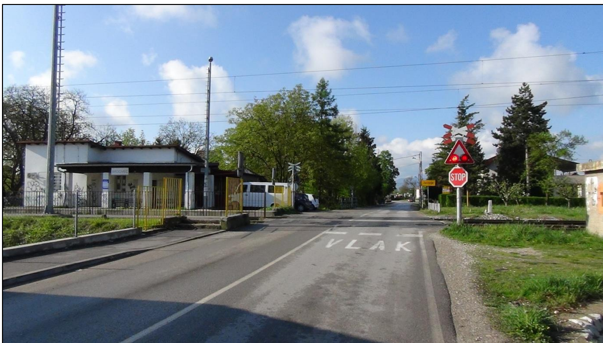
Slika 5. Željezničko-cestovni prijelaz osiguran sa svjetlosno-zvučnom signalizacijom i „Andrijinim križem“, Brdovec
