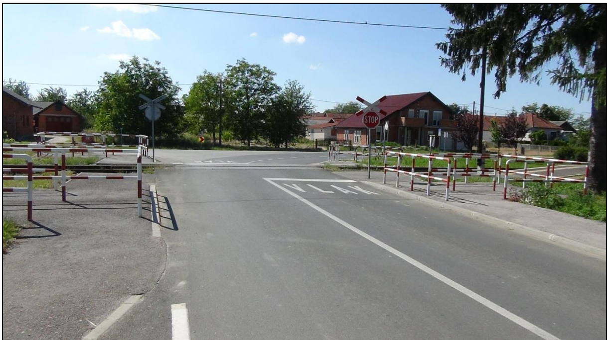
Slika 1. Pasivno osiguran željezničko-cestovni prijelaz, Novo Selo
