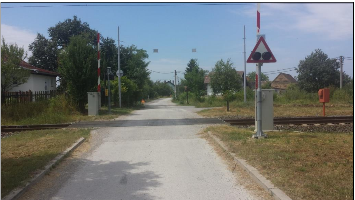
Slika 23. Željezničko-cestovni prijelaz „Lekenik I“ iz smjera sjevera
