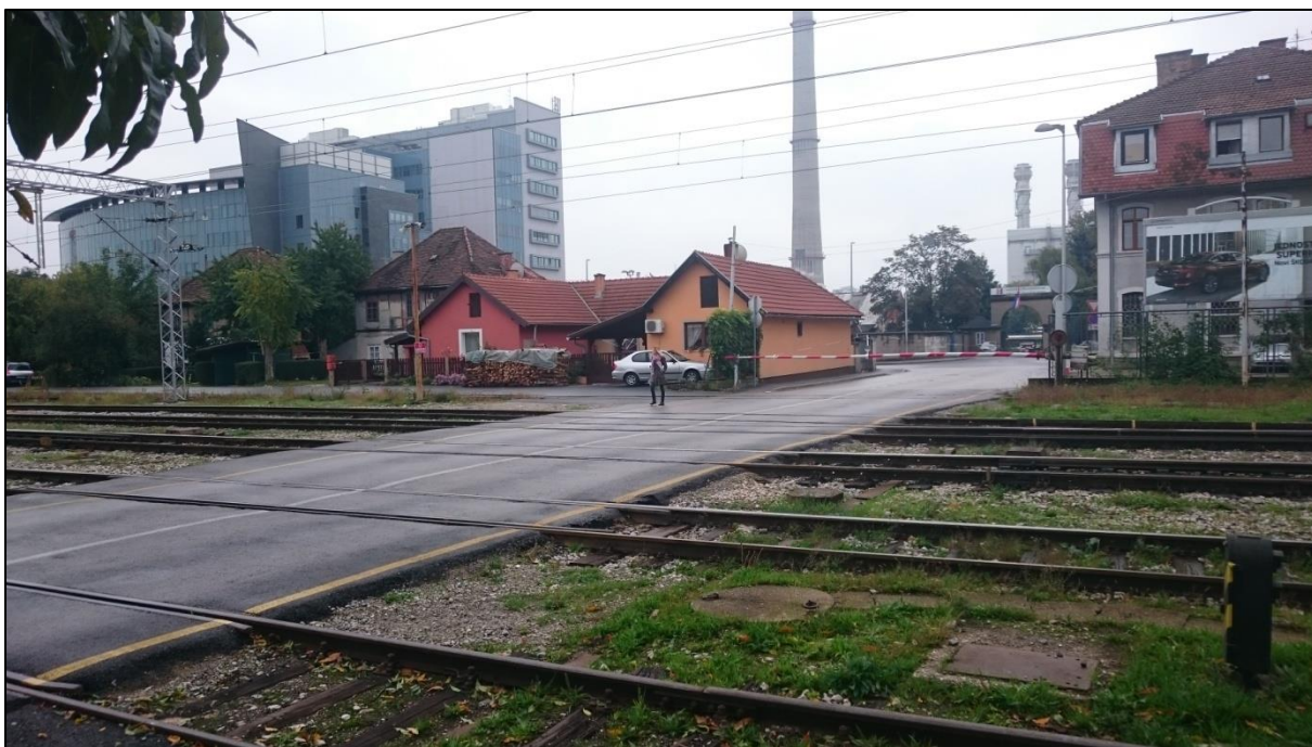
Slika 7. Željezničko-cestovni prijelaz osiguran punim branicima, Vodovodna ulica, Zagreb
