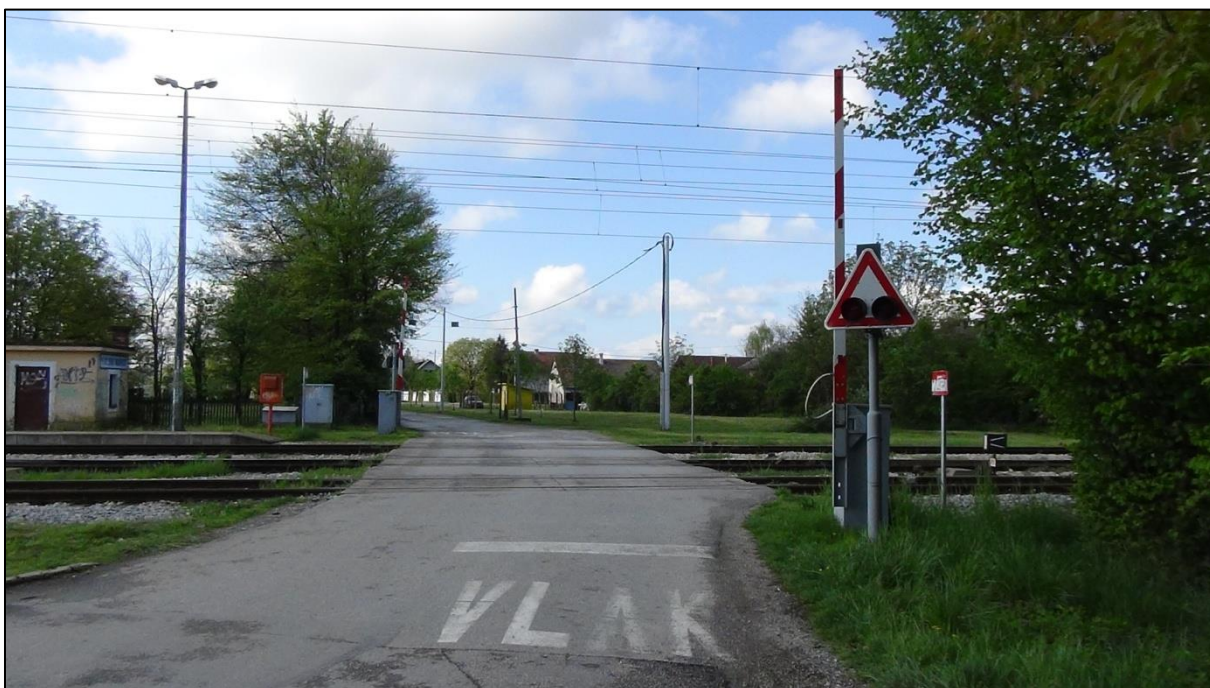
Slika 6. Željezničko-cestovni prijelaz sa svjetlosno-zvučnom signalizacijom i polubranicama, Savski Marof
