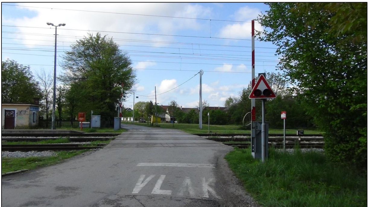
Slika 6. Željezničko-cestovni prijelaz sa svjetlosno-zvučnom signalizacijom i polubranicima, Savski Marof
