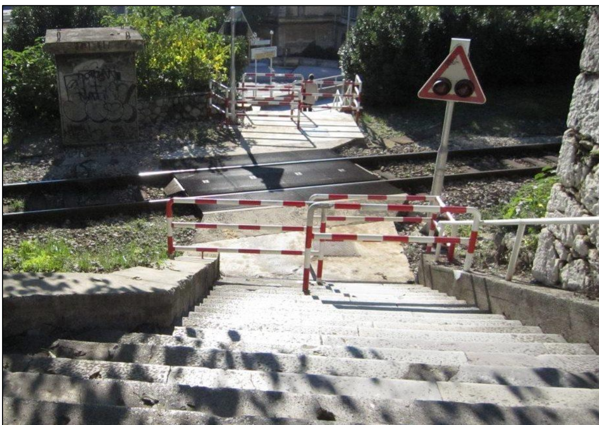
Slika 8. Pješački prijelaz sa svjetlosno-zvučnom signalizacijom i mimoilaznom ogradom za pješake, Rijeka
