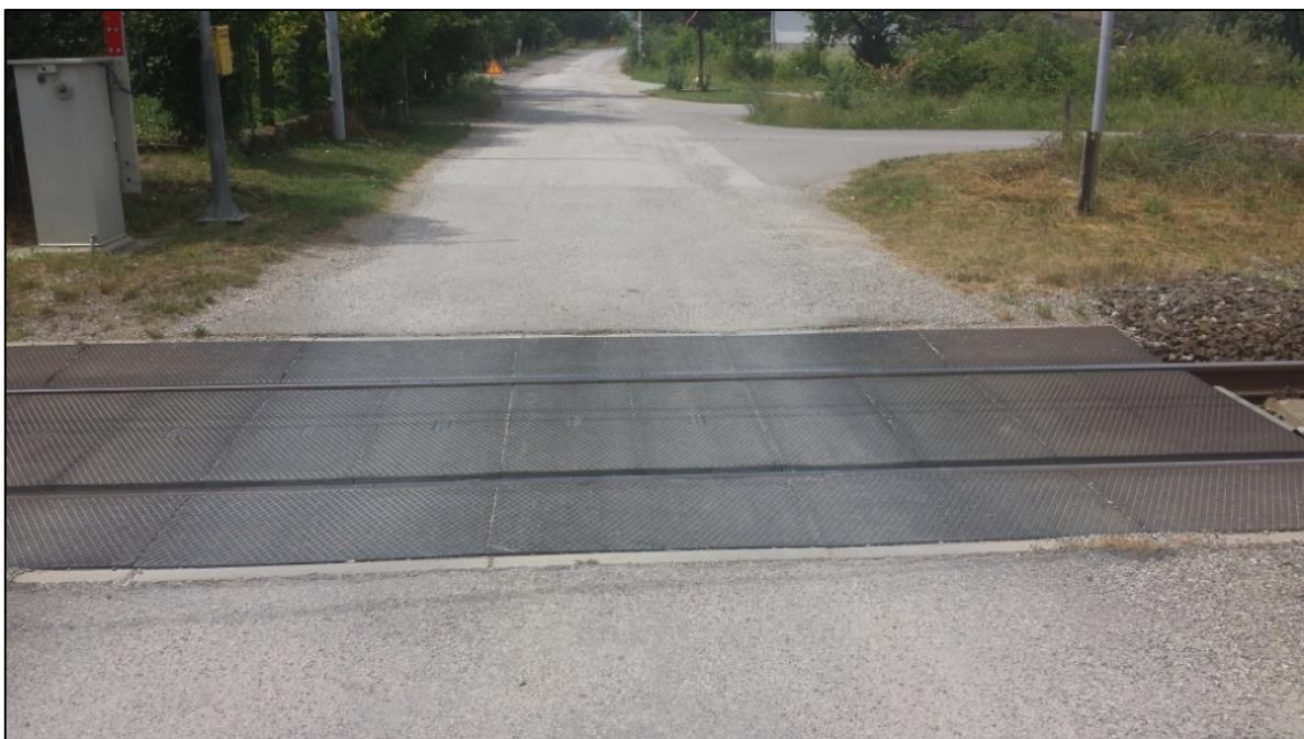
Slika 25. Prikaz podloge na željezničko-cestovnom prijelazu „Lekenik I“
