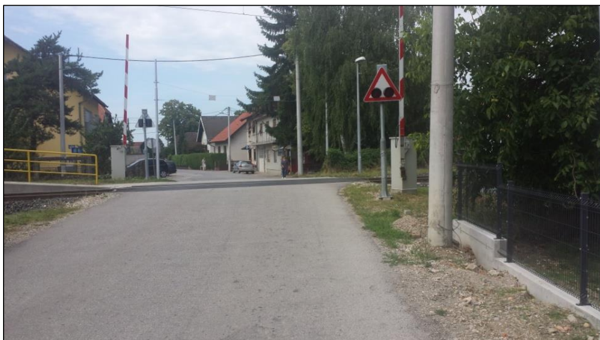
Slika 11. Pogled na željezničko-cestovni prijelaz „Mraclin“ iz smjera juga
