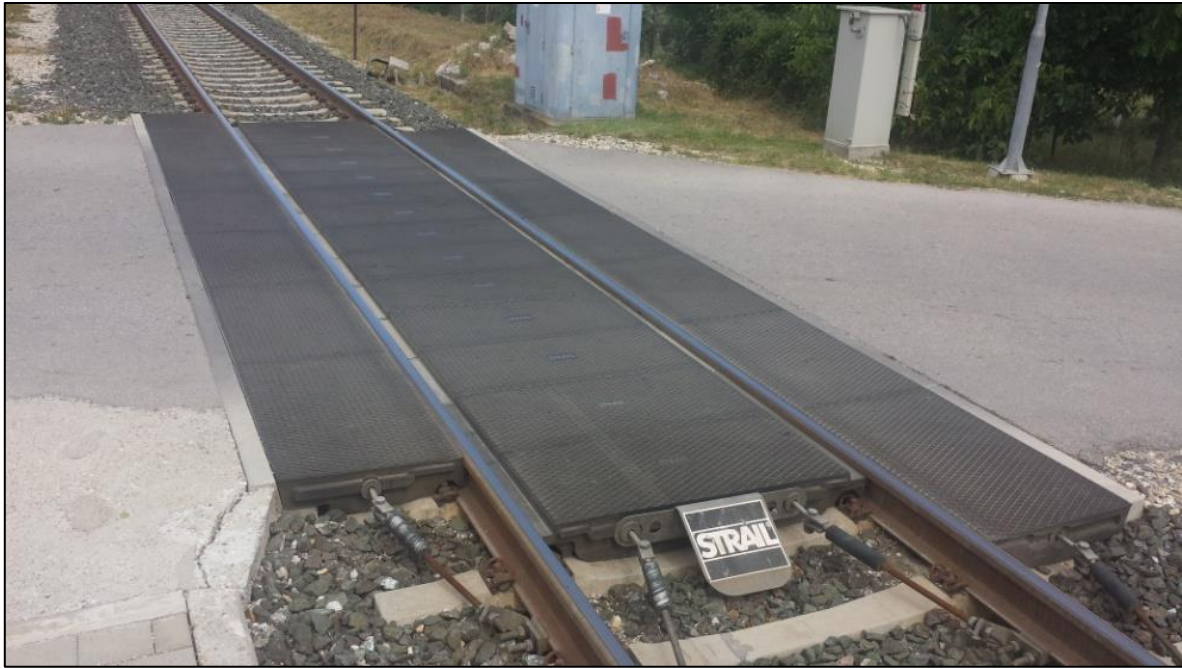
Slika 12. Prikaz prijelaza popločenog „STRAIL“ pločama na željezničko-cestovnom prijelazu „Mraclin“
