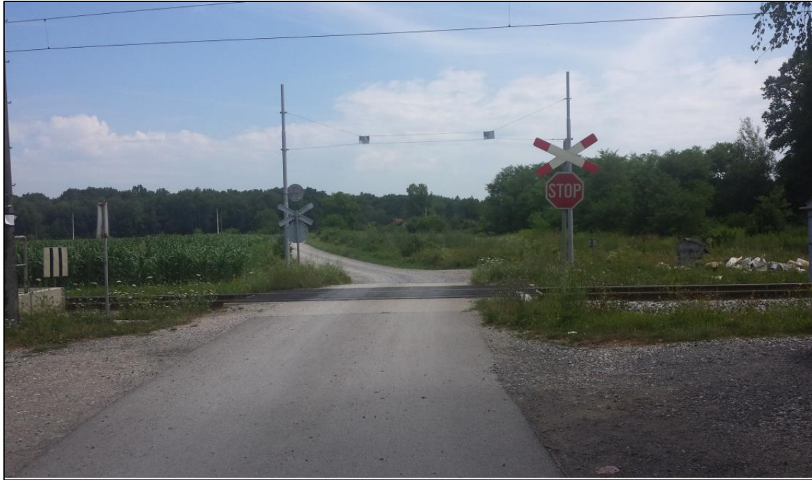
Slika 17. Pogled na željezničko-cestovni prijelaz „Peščenica“ iz smjera juga
