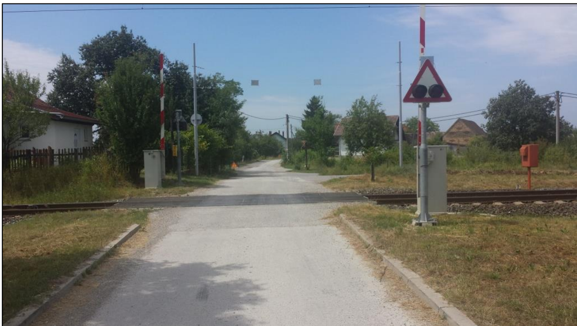
Slika 23. Željezničko-cestovni prijelaz „Lekenik I“ iz smjera sjevera
