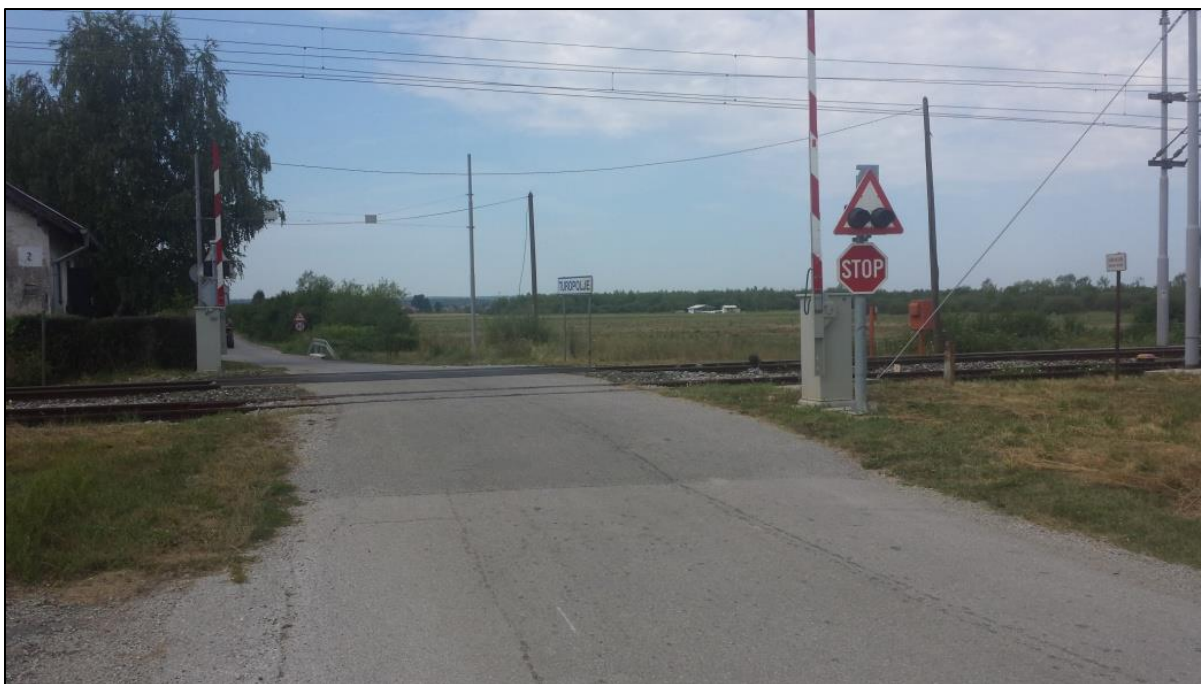
Slika 13. Željezničko-cestovni prijelaz „Turopolje“ iz smjera sjevera
