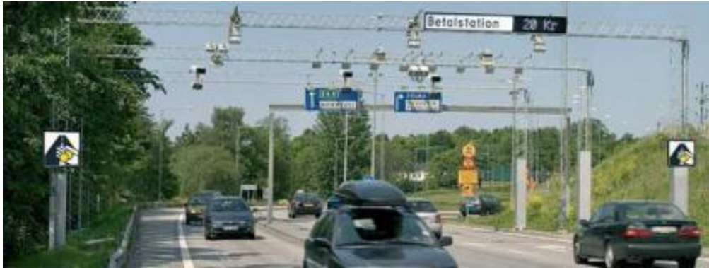
Slika 58. Stockholm. Metoda pra enja ulaza i izlaza vozila u središtu grada pomo u kamera. [48]
