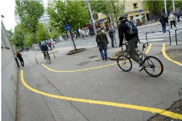
Slika 32. Neispravno iscrtana biciklisti ka staza kod Studentskog centra. [37]
