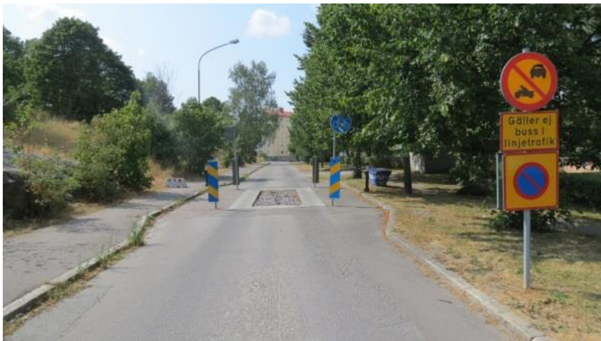
Slika 55. Primjer uspornika na kolniku Izvor: [19]
