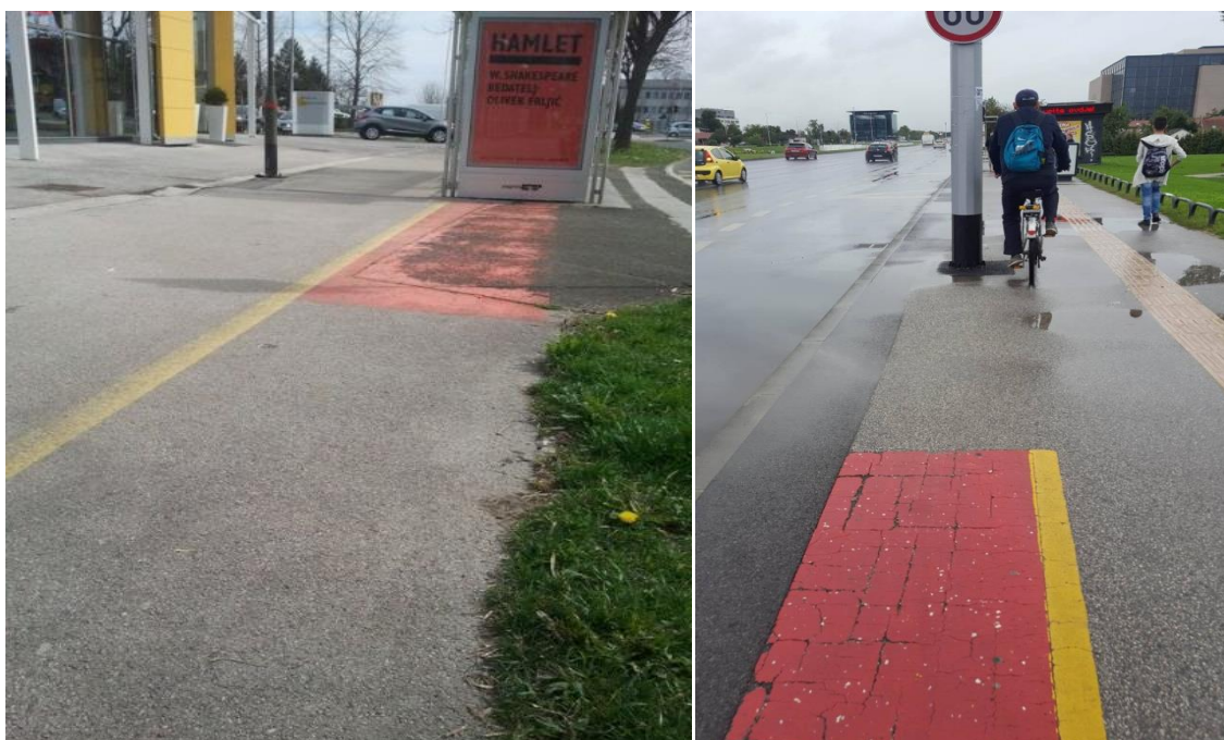
Slika 30. Prekid biciklističke staze kod autobusnog stajališta
