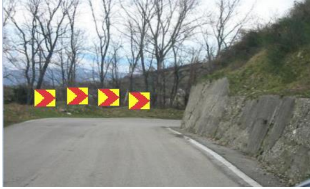
Slika 13. Nepregledni zavoј nakon izvršenja mjera
