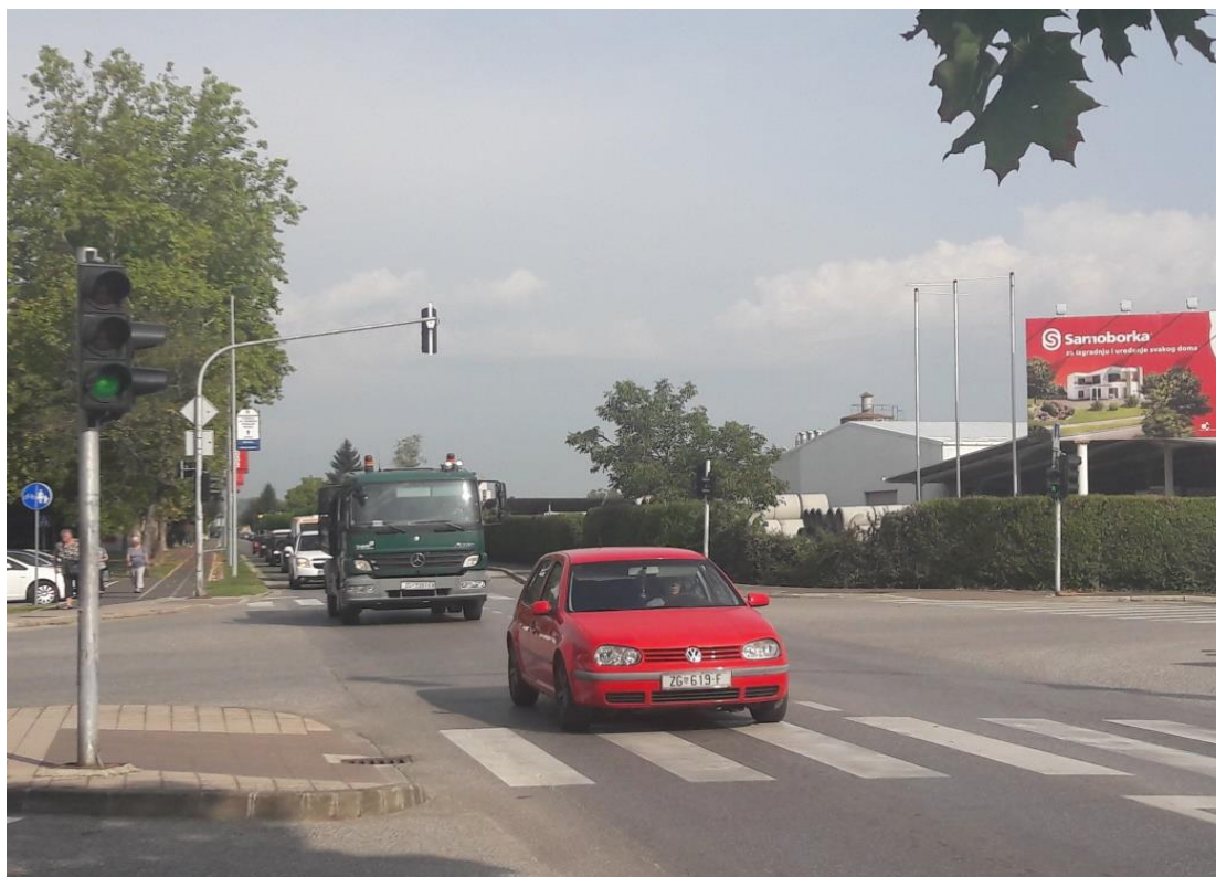
Slika 20: Pogled sa lokacije 1 na promatrano raskrižje
