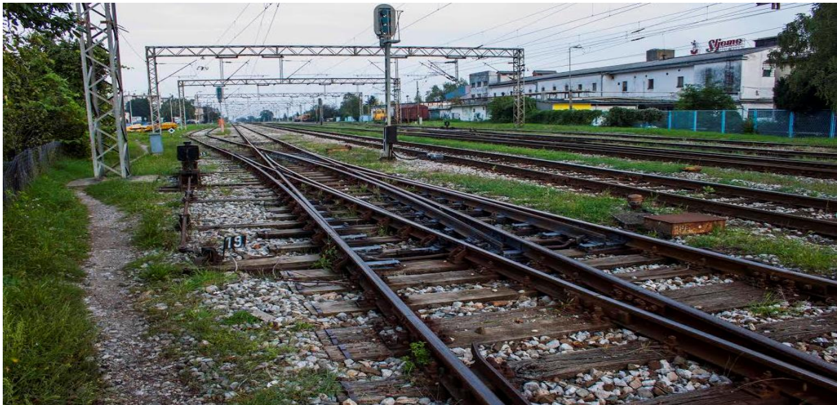
Slika 16. Skretnica (križna, tzv. „Englezer“) broj 19a/b u kolodvoru
