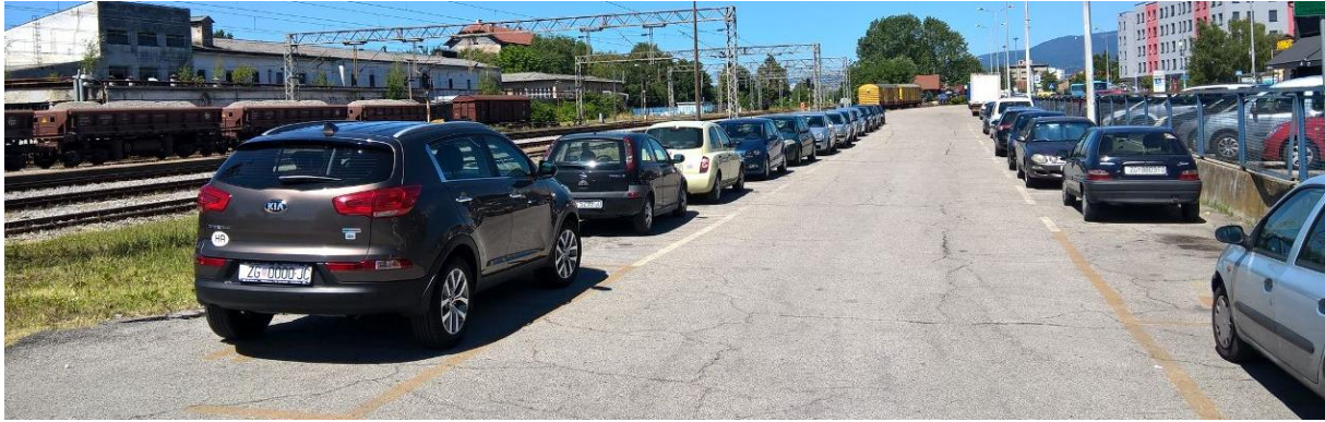
Slika 11. Ograđeno parkiralište unutar kolodvorskog područja (prostor bivše utovarno – istovarne rampe)
