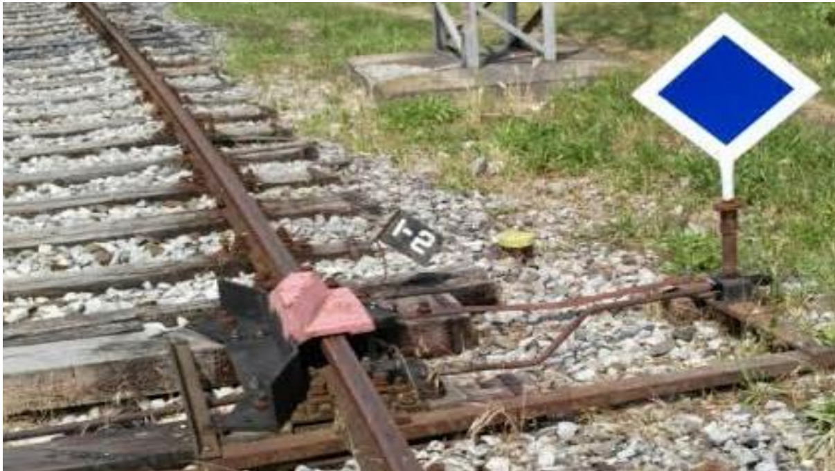
Slika 18. Iskliznica 2/I na prvom kolosijeku
