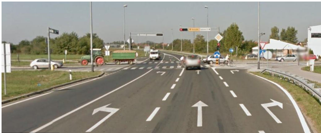
Slika 9: Km 4+587- 4+747, zona zahvata na D3, dionica 003, iz smjera Goričana
