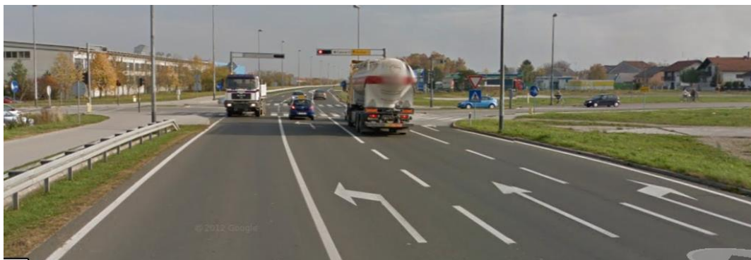
Slika 10: Km 4+587 – 4+747, zona zahvata na D3, dionica 003, iz smjera Varaždina
