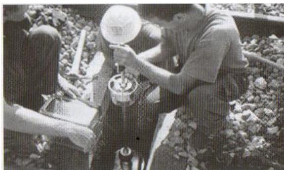
Slika 12. Ispitivanja dinamičkom pločom
