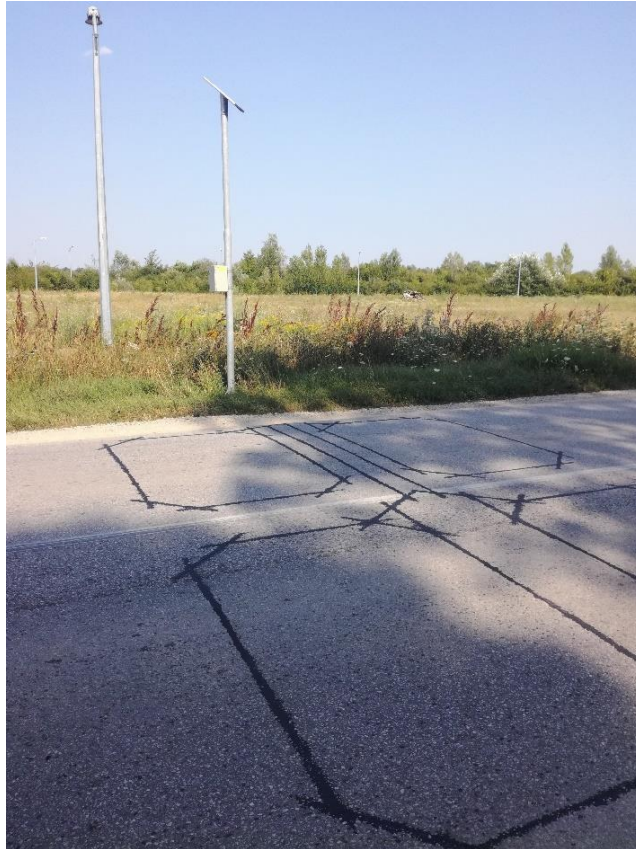
Slika 7. Neprekidno automatsko brojilo prometa s tehnologijom induktivnih petlji napajano putem solarnog panela
