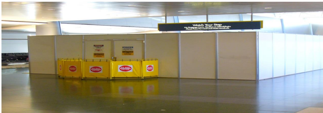
Slika 9. Zaštitni zidovi unutar terminala
