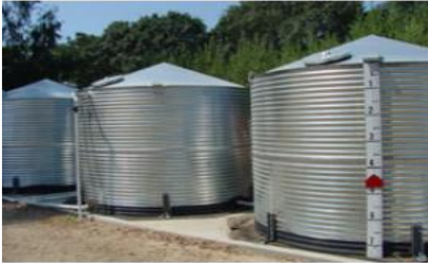
Slika 13. Nadzemni spremnici za skladištenje plina i opasnih tekućina
