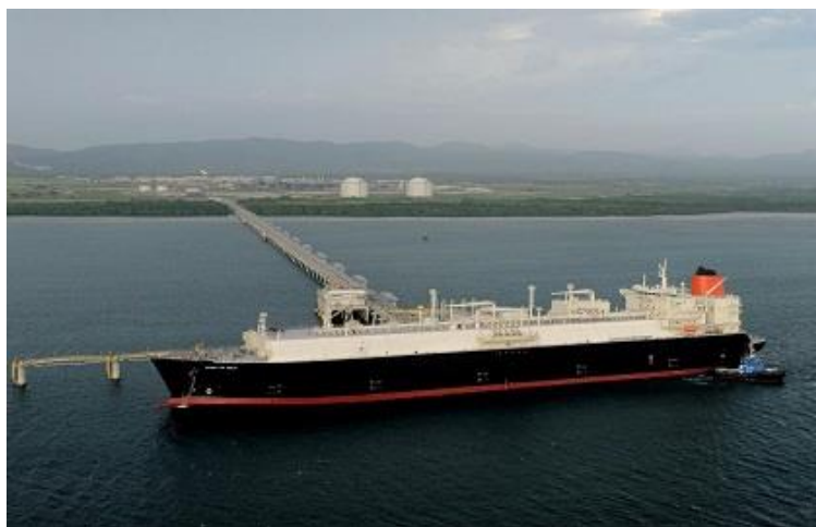
Slika 5: Iskrcaj UPP-a na prihvatni terminal
