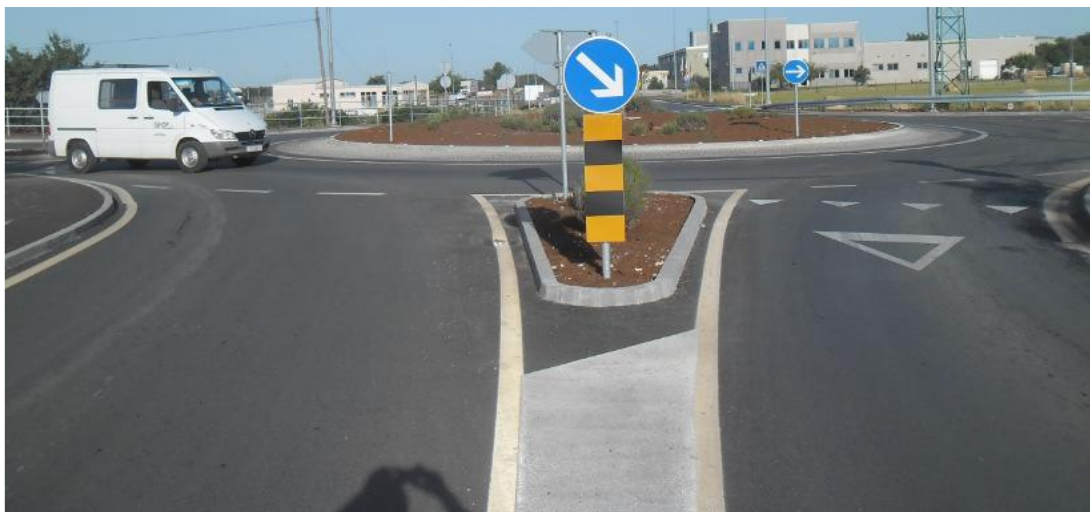
Slika 5. Razdjelni otok unutar površine za razdvajanje prometa, [3]
