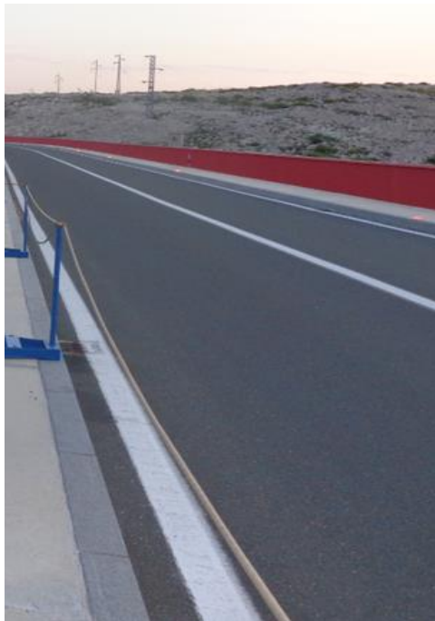
Slika 1. Rubne crte u funkciji optičkog vođenja
