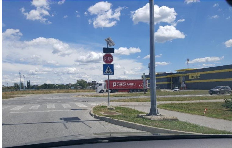
Slika 58: Prometni znak opremljen dodatnim treptačima
