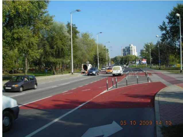
Slika 63. Protuklizne prometne površine, [43]
