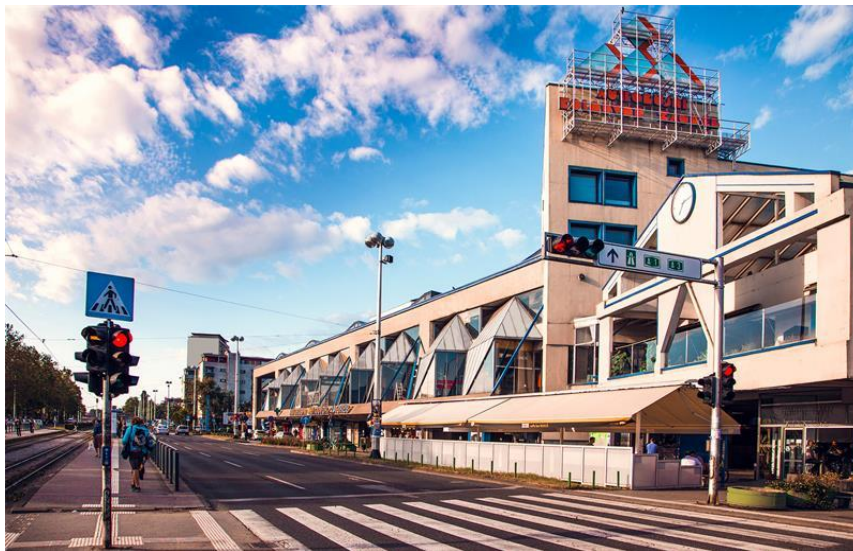
Slika 2.1. Današnji izgled Autobusnog kolodvora Zagreb, [3]
