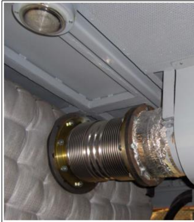
Slika 20. Ispušni lonac sa spojem na ispušnu granu
