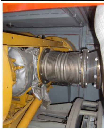
Slika 19. Spoj ispuha motora na ispušni lonac
