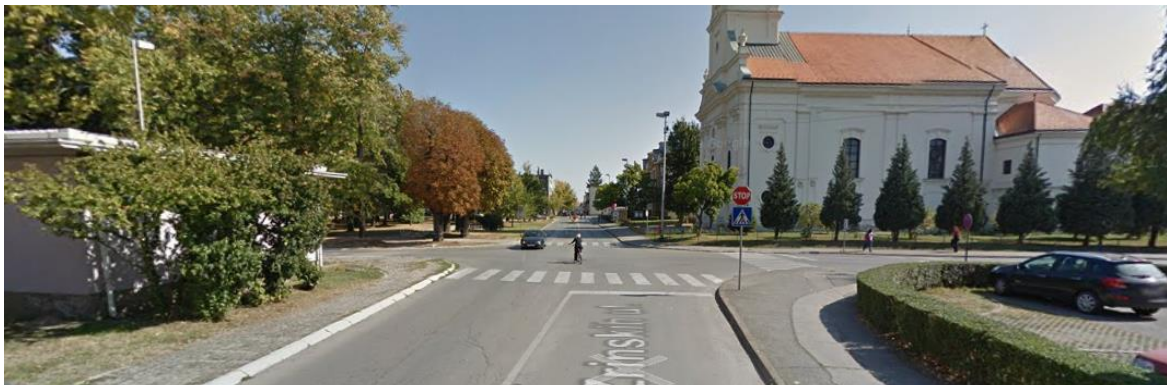
Slika 3.6. Horizontalna preglednost na raskrižju 1 (zapadni privoz), [1]
