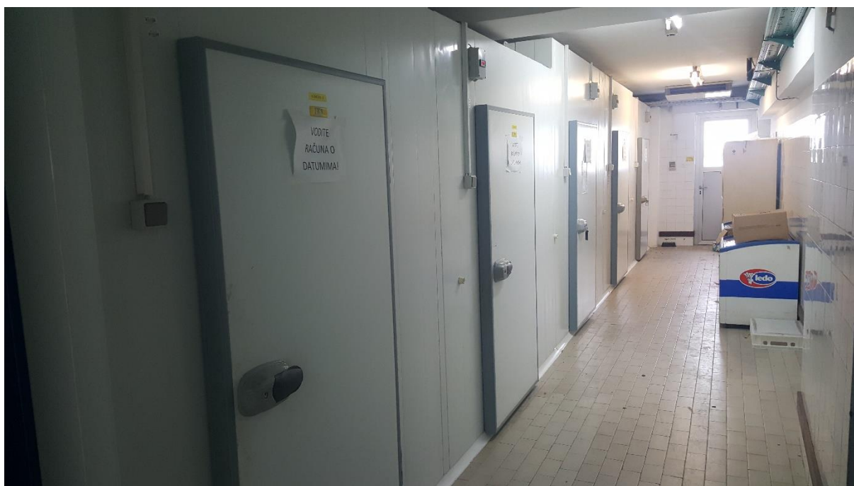
Slika 11. Skladište sirovina (temperaturne komore)
