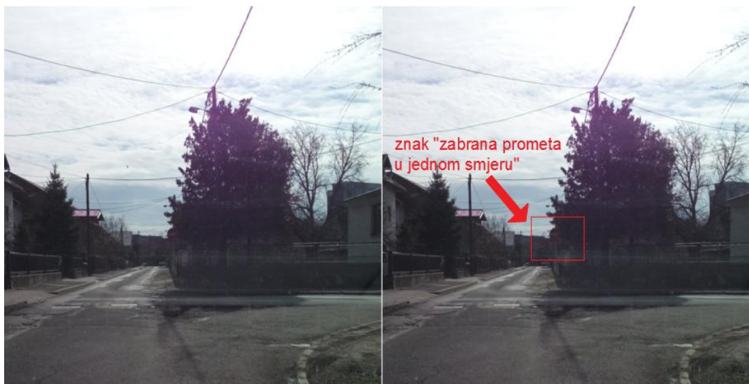
Slika 46. Primjer prometnog znaka koji je zaklonjen zelenilom i teško vidljiv vozačima
