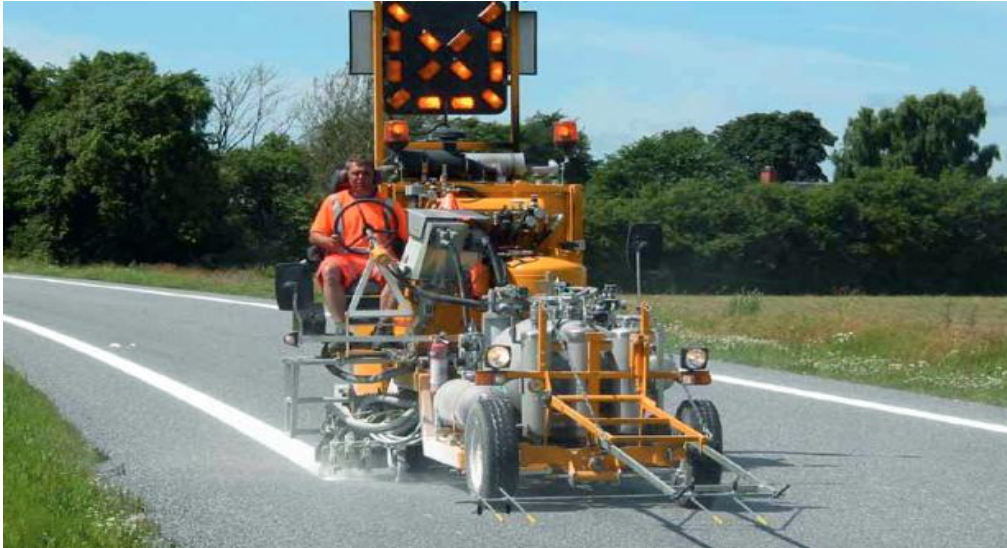
Slika 37. Nanošenje boje na kolnik
