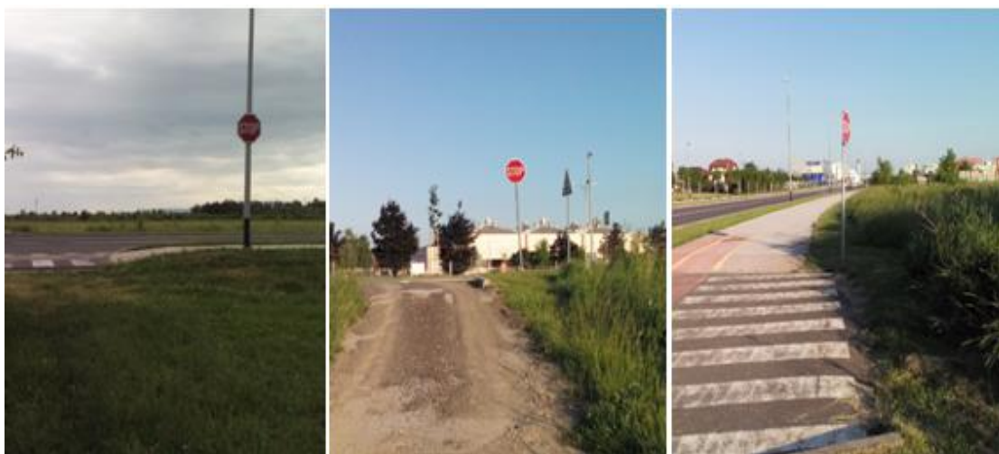
Slika 57. Primjeri nepotrebno postavljenih znakova „obvezno zaustavljanje“
