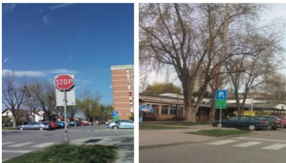
Slika 54. Primjer znaka „obvezno zaustavljanje“ zaklonjenog drugim znakom
