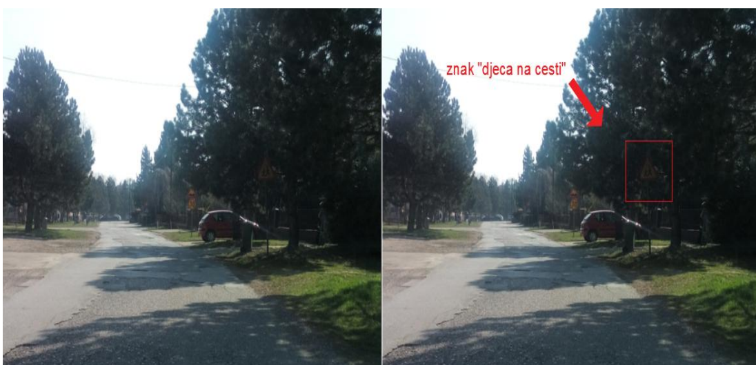
Slika 45. Primjer prometnog znaka koji je zaklonjen zelenilom i teško vidljiv vozačima
