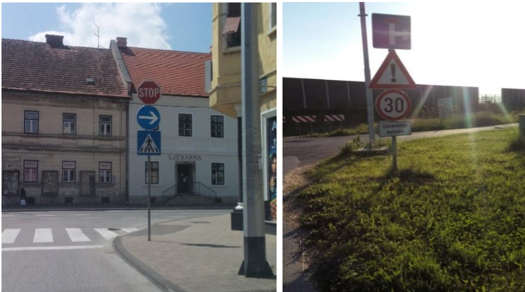
Slika 48. Primjer prometnih znakova kojih je postavljeno više od dva na isti stup
