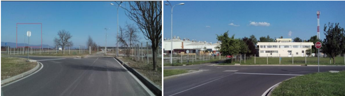
Slika 56. Primjer nepotrebno postavljenog znaka „obvezno zaustavljanje“
