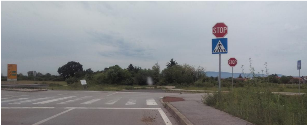
Slika 58. Primjer dva puta postavljenog znaka „obvezno zaustavljanje“
