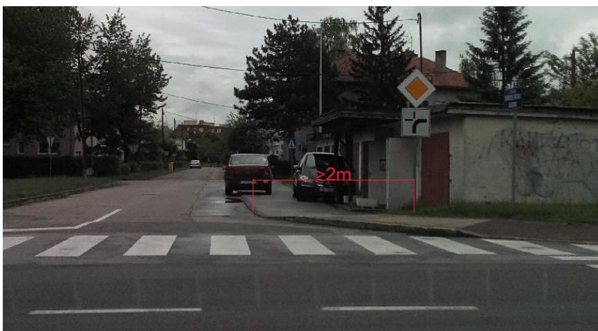
Slika 51. Primjer prometnog znaka koji je postavljen predaleko od ruba kolnika
