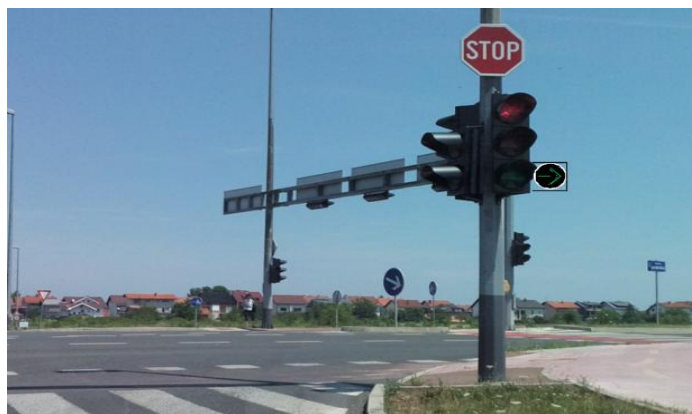
Slika 90. Postavljanje dopunskih svjetlećih strelica
