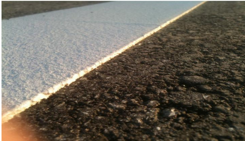
Slika 38. Oznaka na kolniku izrađena hladnom plastikom
