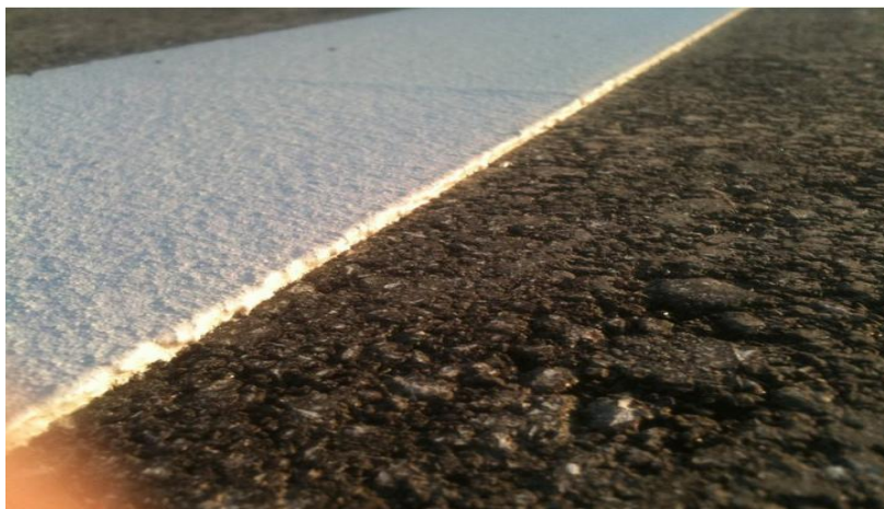
Slika 38. Oznaka na kolniku izrađena hladnom plastikom
