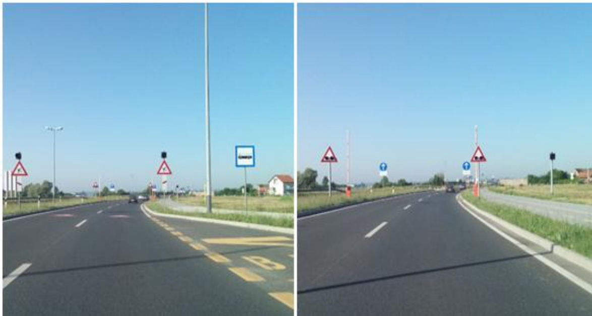
Slika 60. Svjetlosni znakovi i branici za zatvaranje prometa na istočnoj obilaznici
