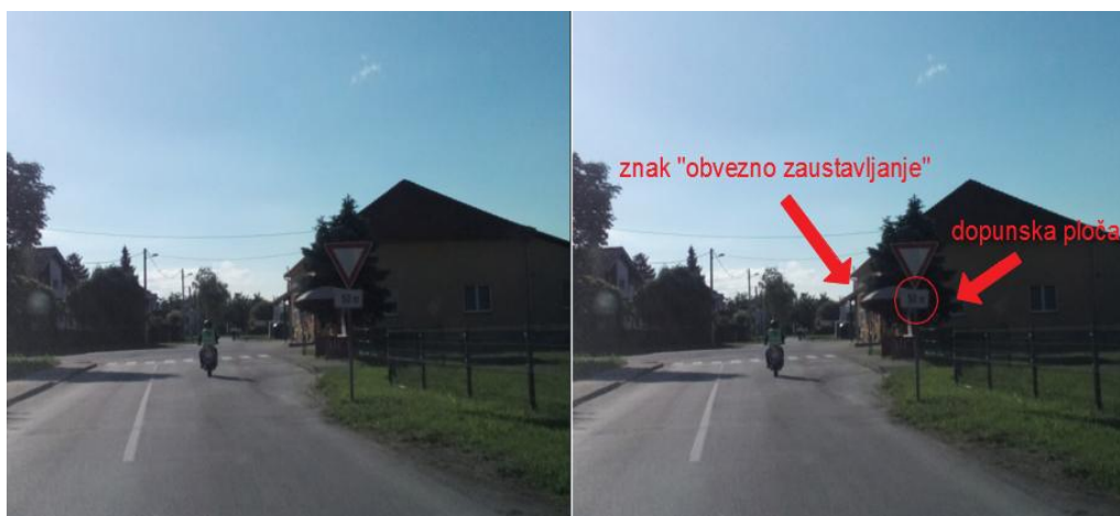
Slika 50. Primjer prometnog znaka koji nije postavljen u skladu s Pravilnikom
