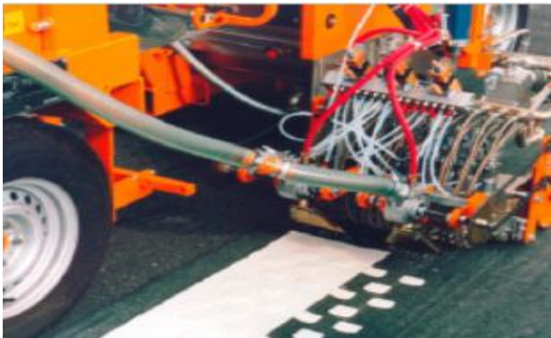
Slika 39. Oznaka na kolniku izrađena termoplastikom
