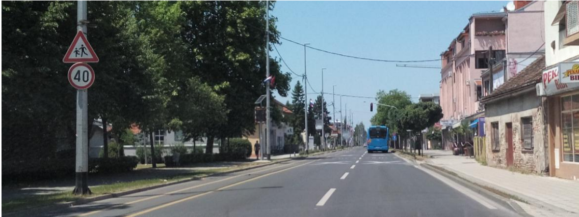
Slika 52. Primjer prometnog koji je postavljen samo s lijeve strane ceste uz kolnik
