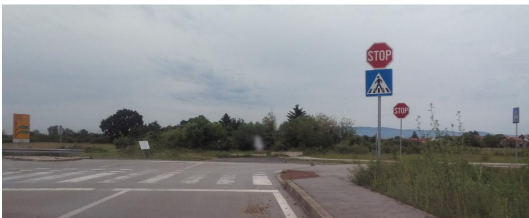
Slika 58. Primjer dva puta postavljenog znaka „obvezno zaustavljanje“
