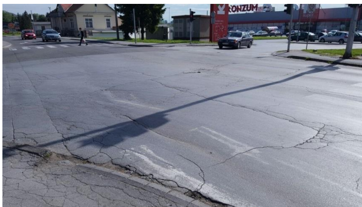
Slika 17. Prikaz horizontalne signalizacije i asfaltne površine na analiziranom raskrižju
