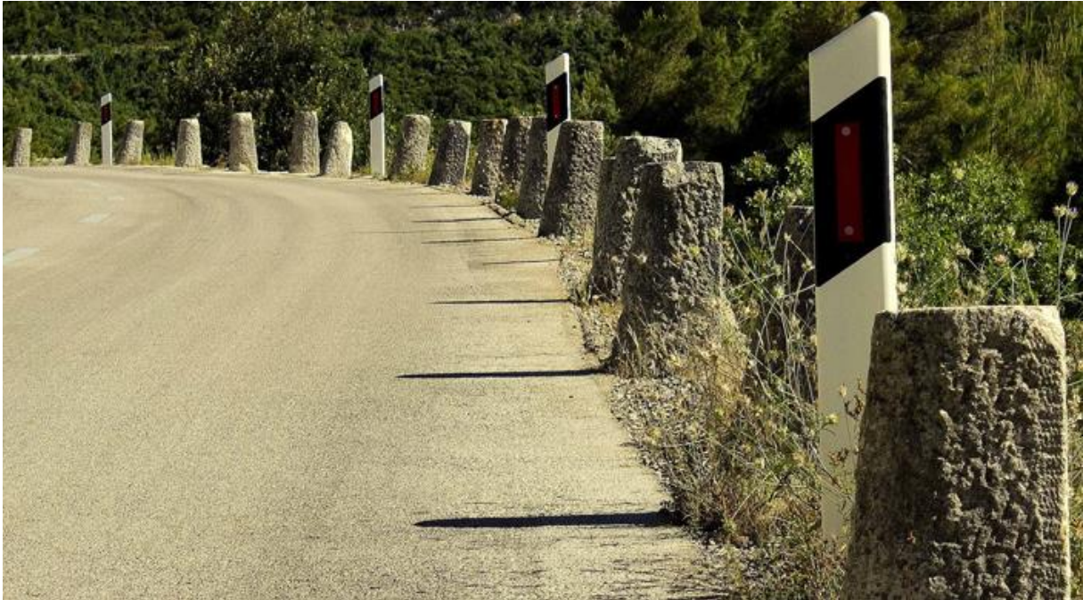
Slika 11. Kolobrani - betonski stupići
