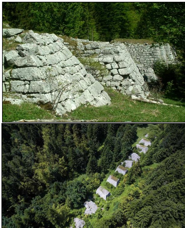
Slika 6. Fajeri – kameni potpornji mosta na Karolini
