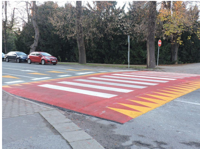
Slika 18. Uzdignuta ploha s pješačkim prijelazom u Varaždinu [19]
