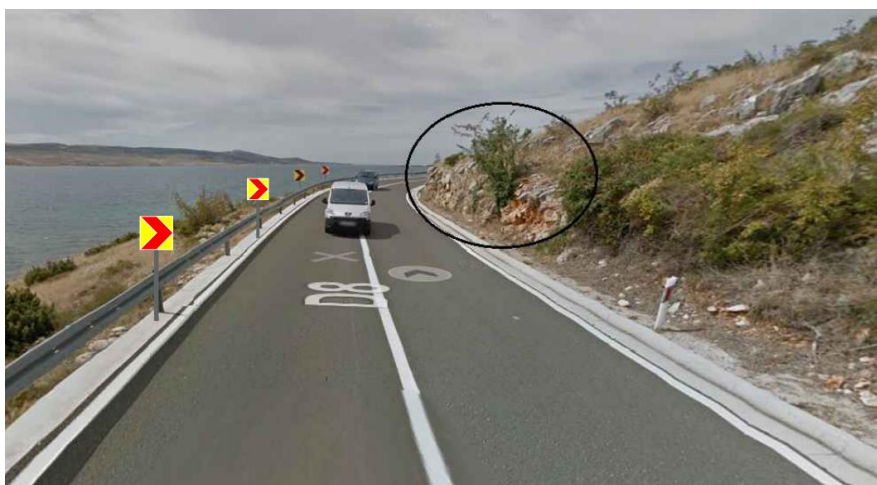
Slika 13. Prijedlog rješenja sa označavanjem oštrog zavoja na cesti
