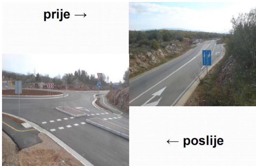
Slika 51. Prikaz sanacije opasnog mjesta izgradnjom rotora (23)
