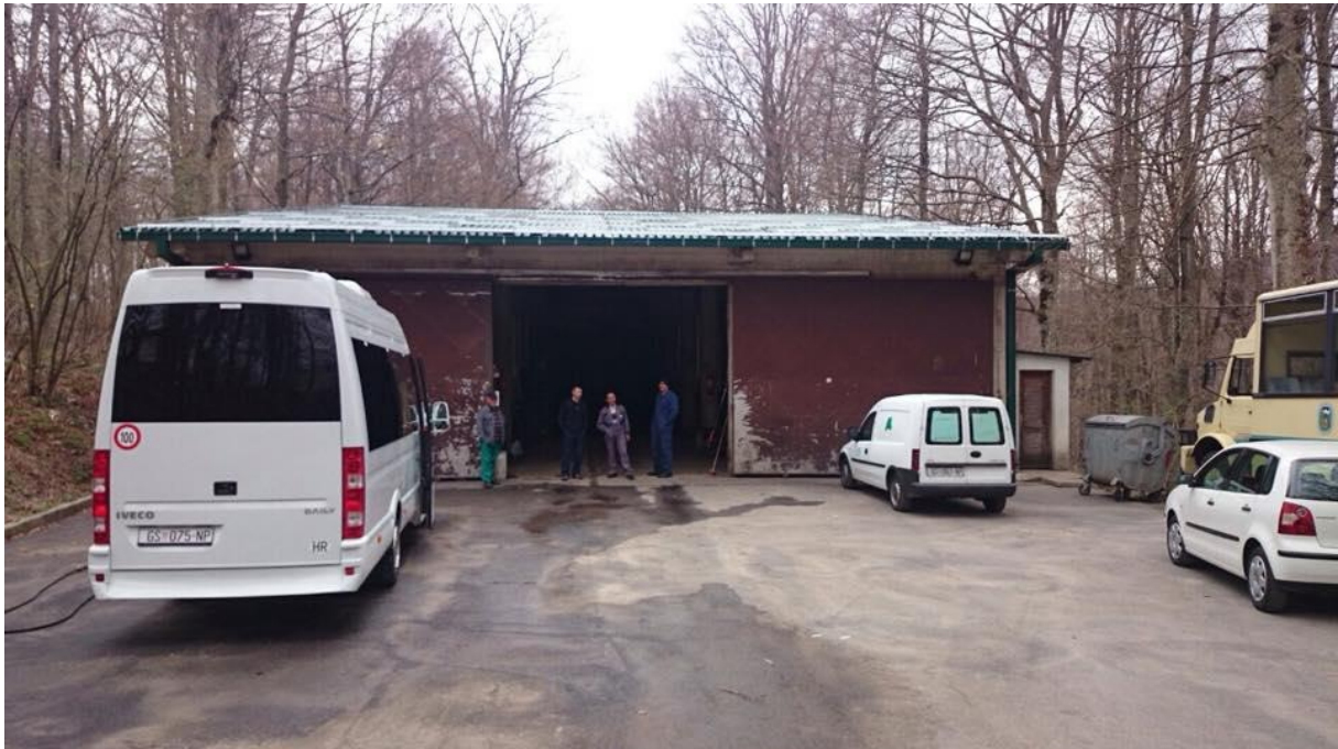
Slika 9. Servisna garaža na Mukinjama
