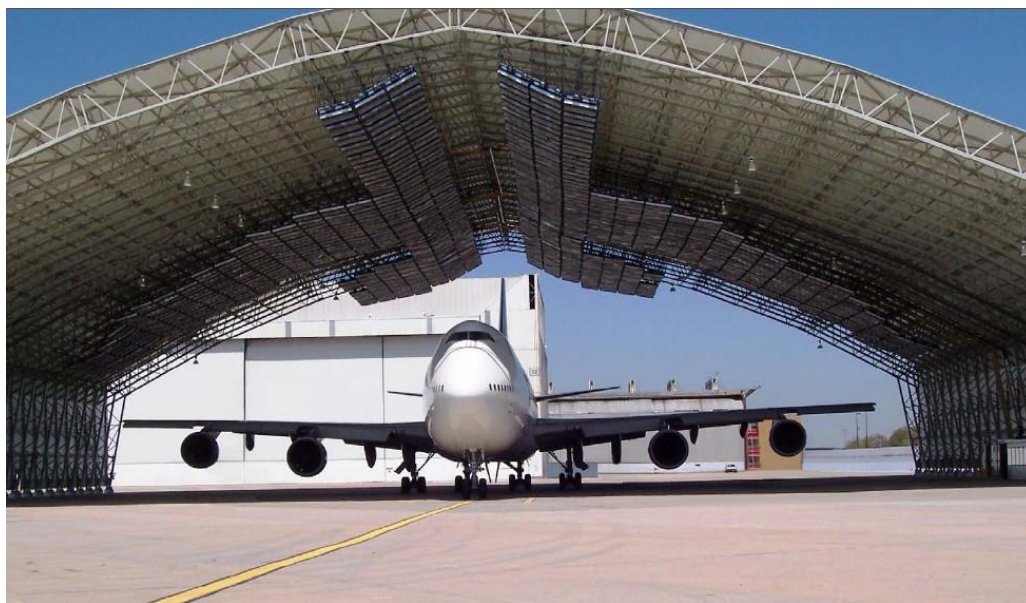
Slika 10. Hangar za odleđivanje zrakoplova infracrvenom tehnologijom
