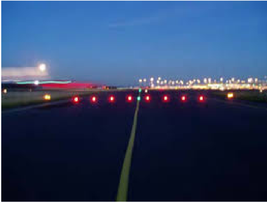
Slika 13. Svjetla prečke za zaustavljanje
