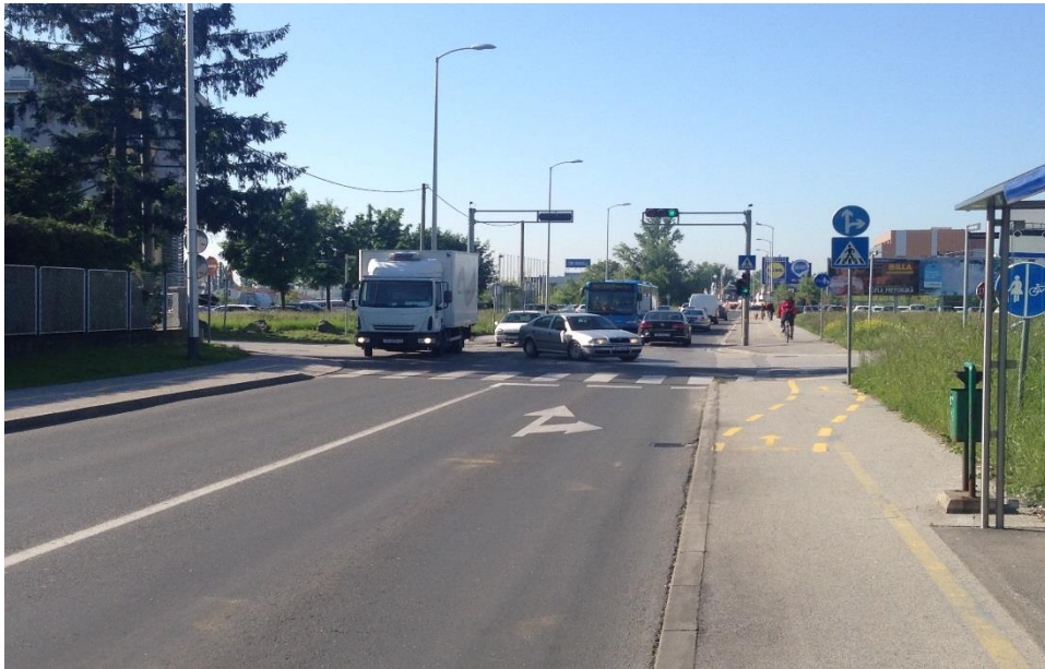
Slika 3. Sjeverni privoz raskrižju
