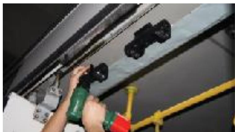
Slika 8. Montaža senzora
