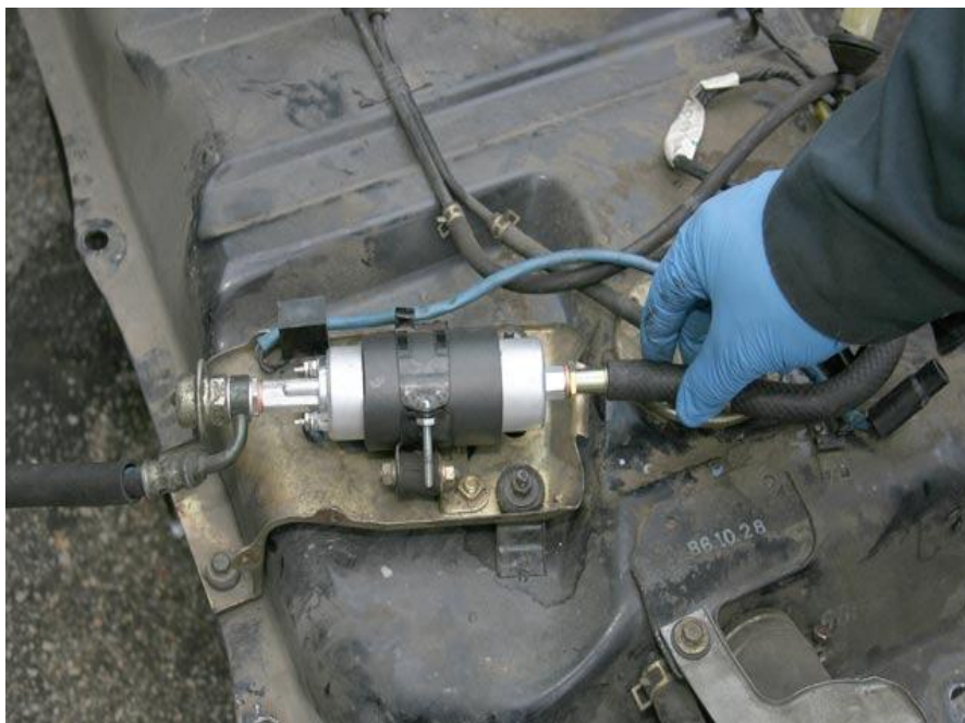
Slika 10. Pumpa goriva izvan spremnika [11]
