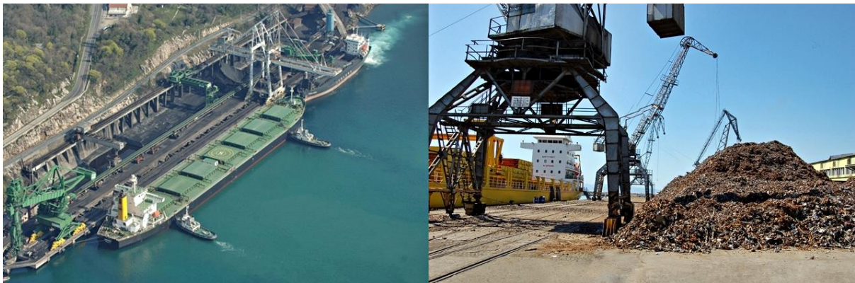
Slika 5. Terminal za rasute terete
