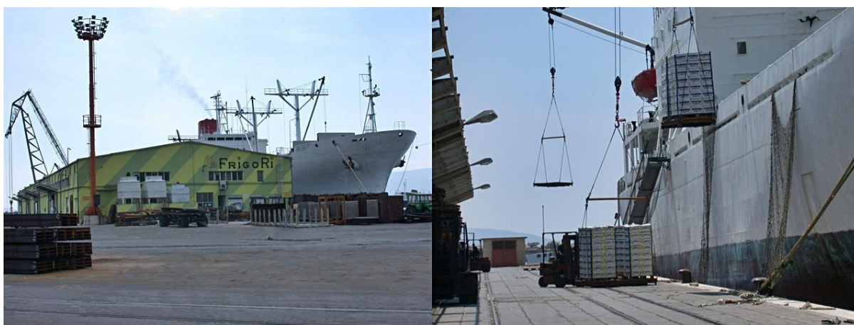
Slika 11. Terminal za kondicionirane terete
