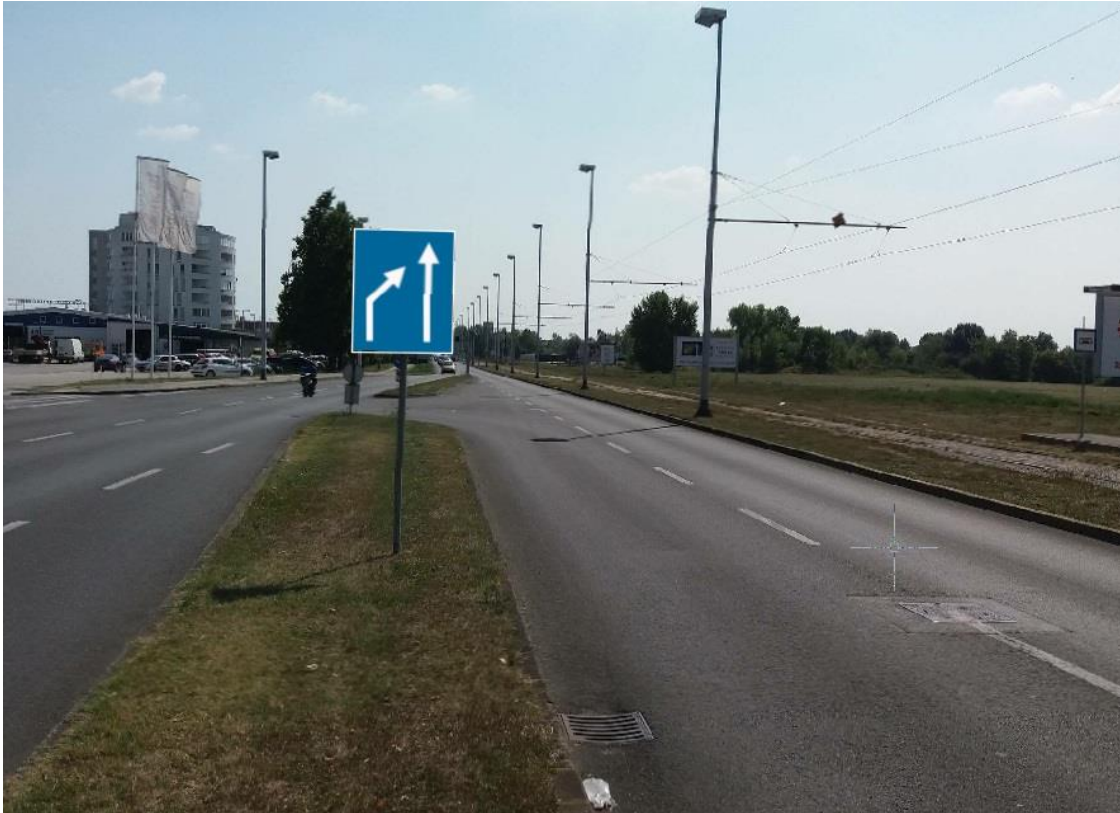
Slika 21. Postavljen prometni znak C92 umjesto postojećeg znaka A16
