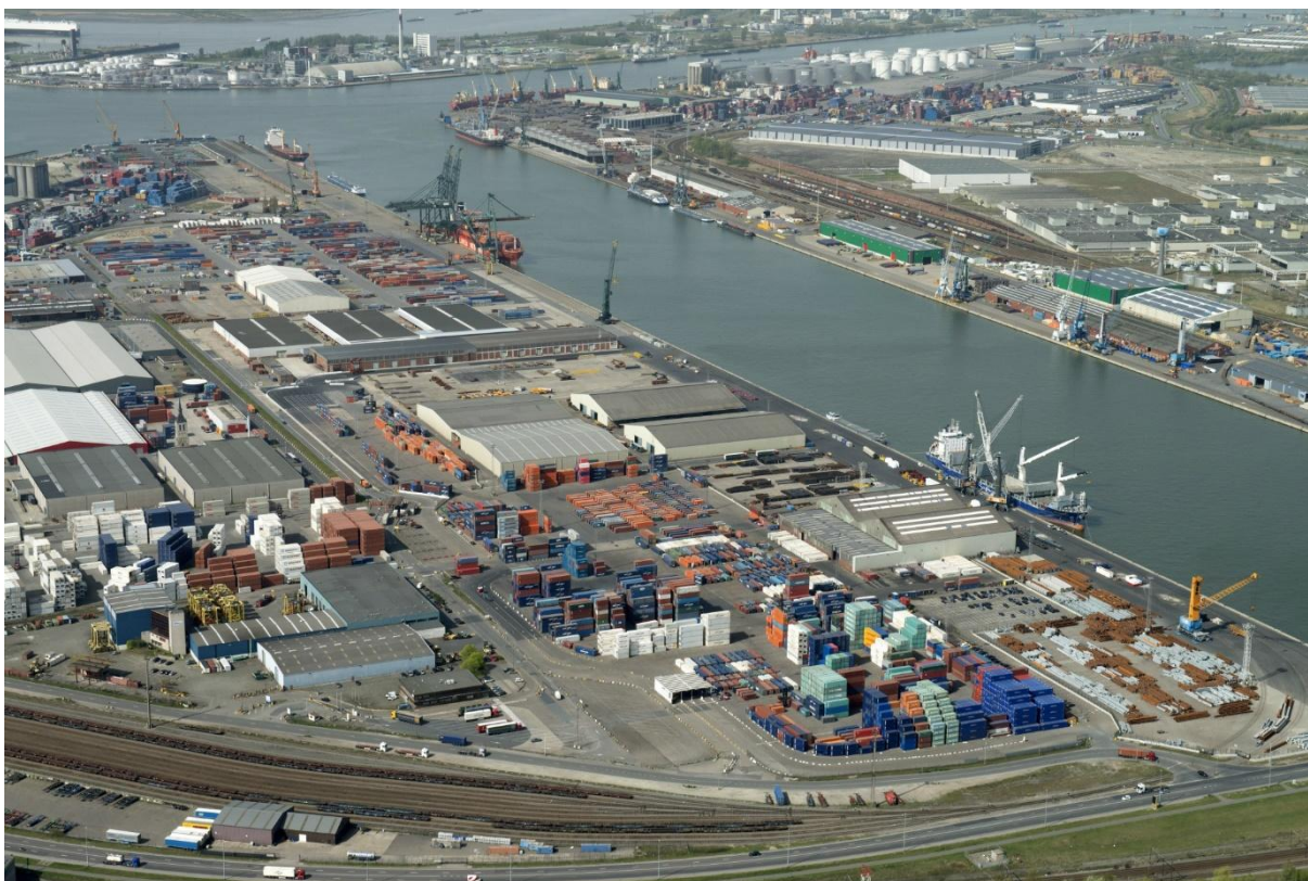
Slika 22 PSA / NHS Churchill Terminal sa skladištima
