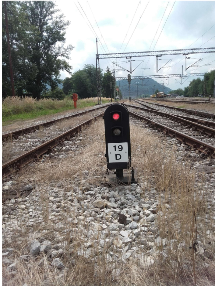
Slika 4. Manevarski signal u kolodvoru Zaprešić
