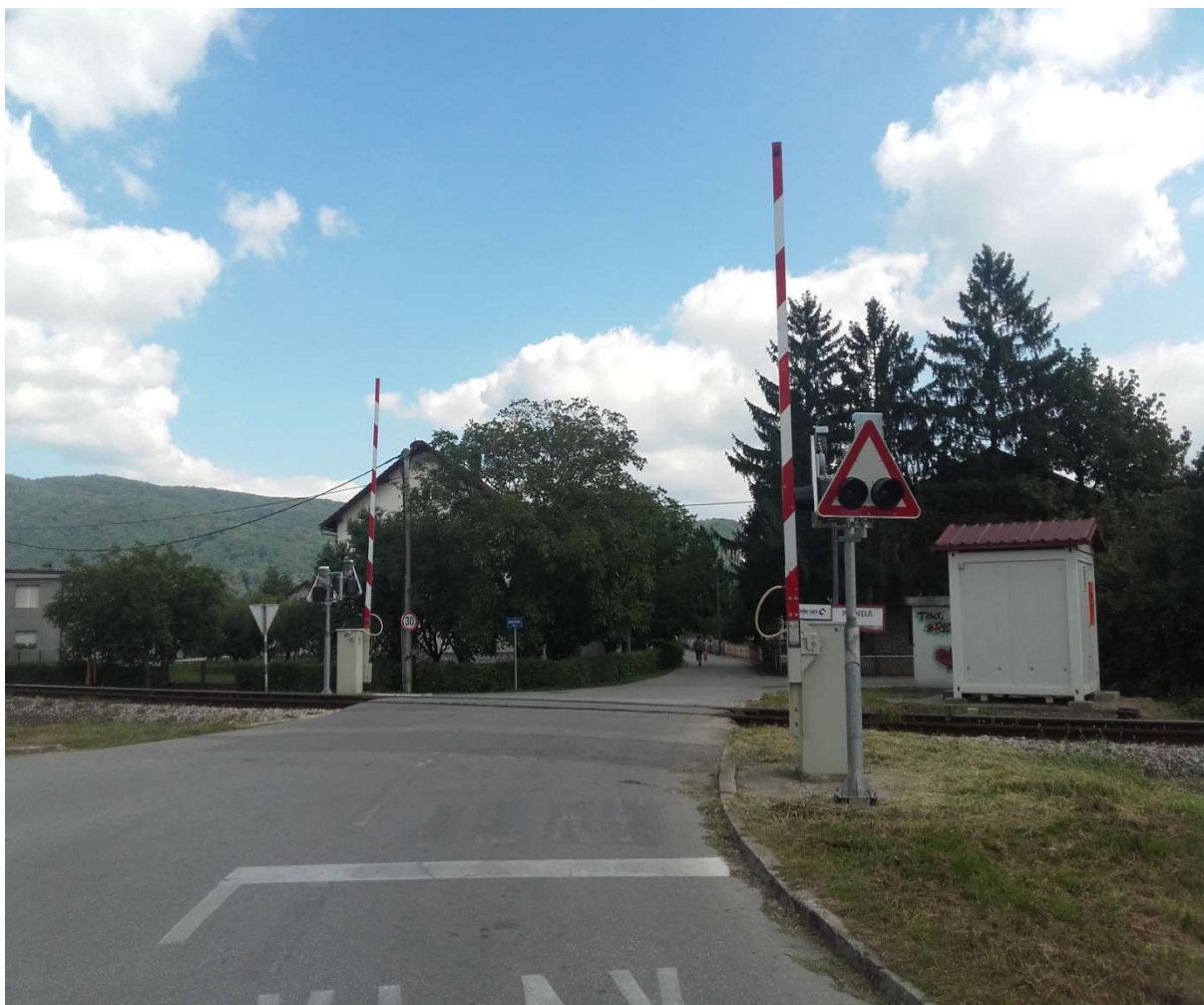
Slika 11. Željezničko – cestovni prijelaz broj 76 A1
