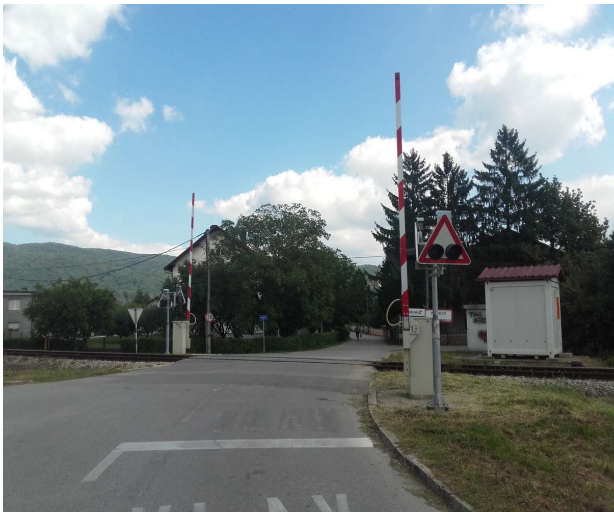
Slika 11. Željezničko – cestovni prijelaz broj 76 A1
