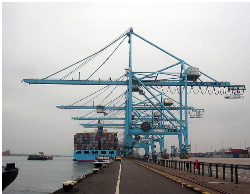
Slika 13: Super-post-Panamax dizalice u luci Rotterdam Izvor: http://www.konecranes.com/ (kolovoz, 2015.)
