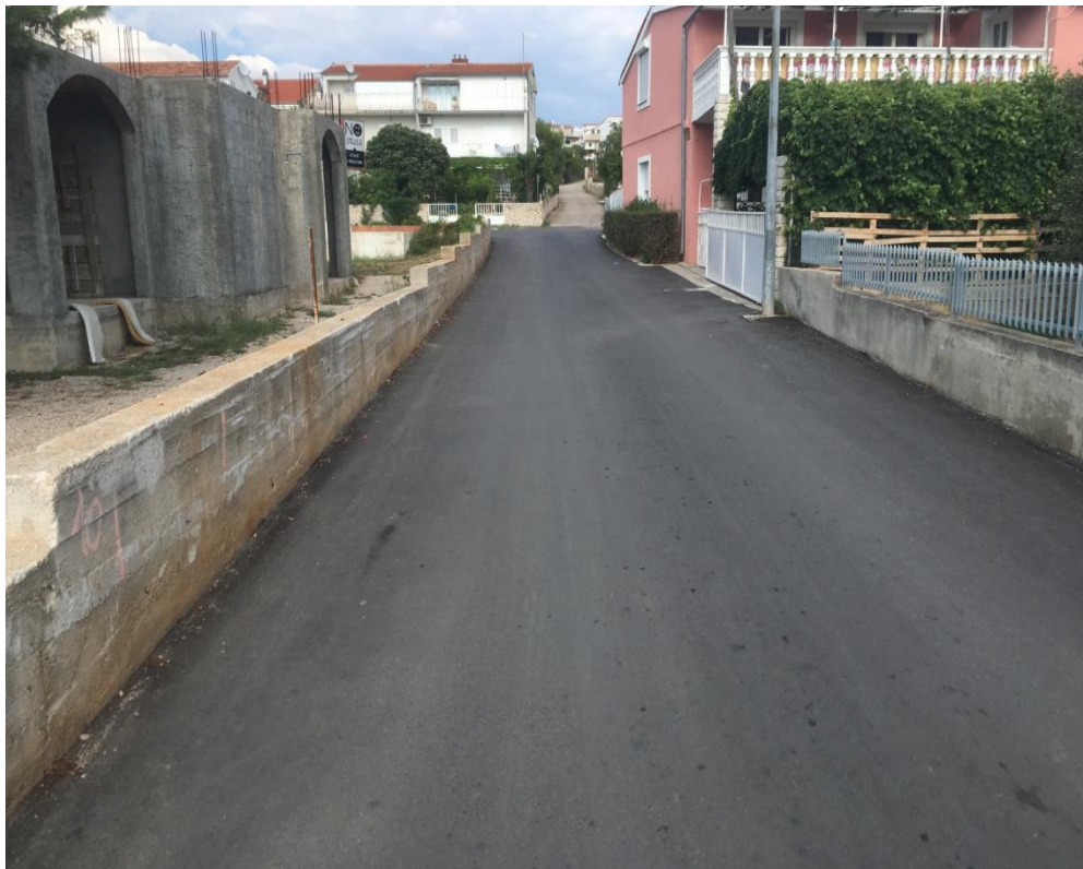
Slika 7. Dio ulice Obala 4. Kolovoza 1941 (smjer Zapad-Istok)
