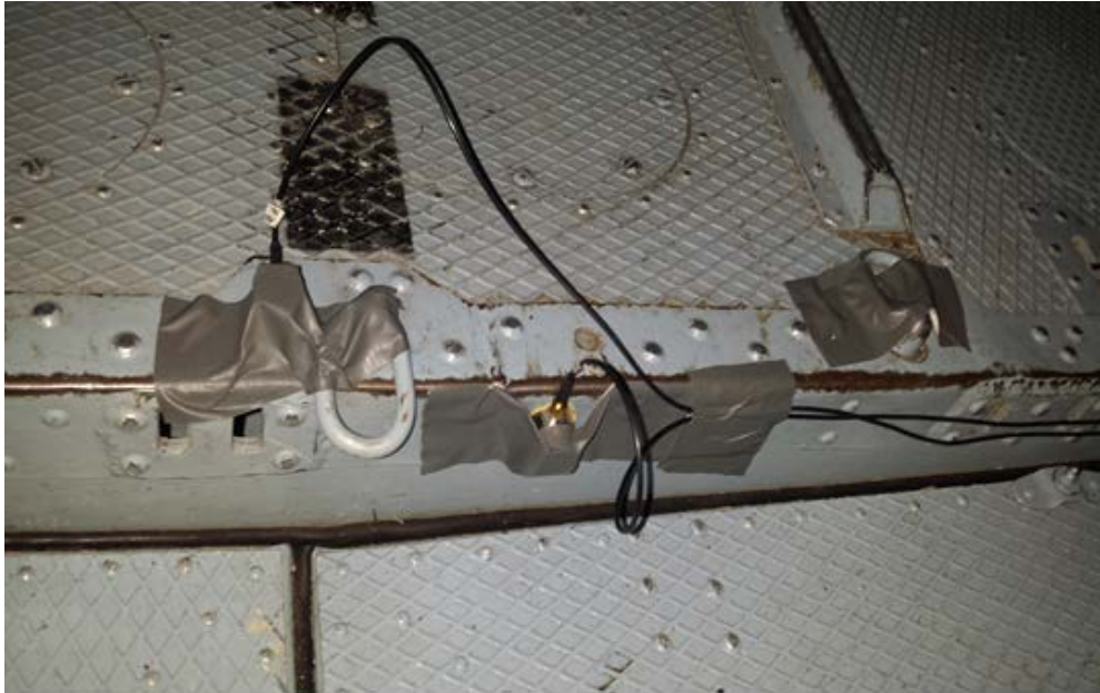
Slika 52. Dva jednoosna akcelerometra postavljena u teretnom prostoru
