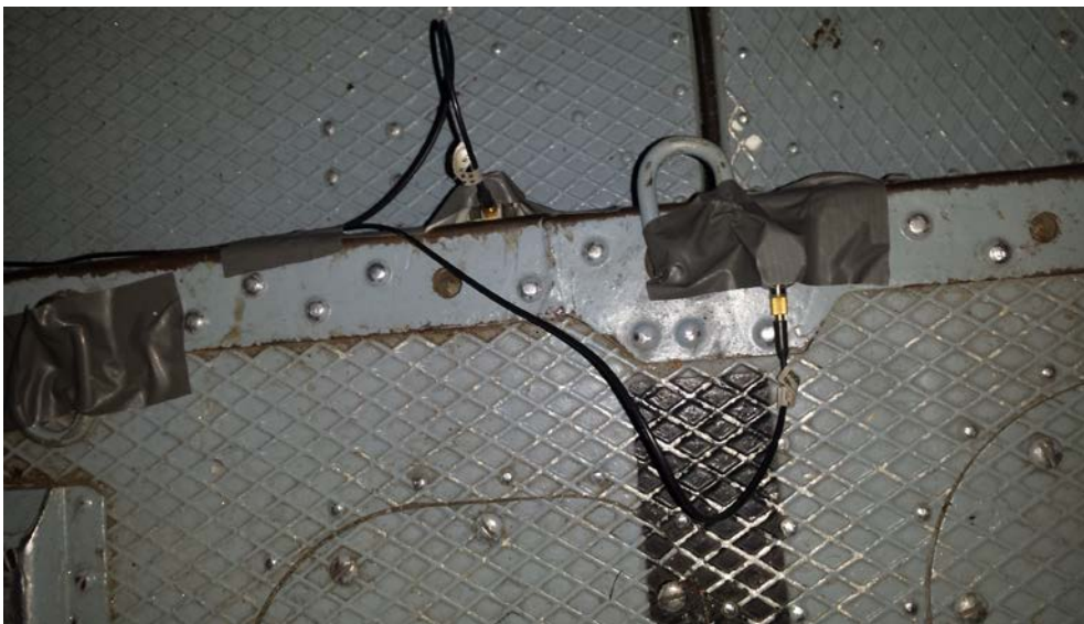
Slika 51. Dva jednoosna akclerometra postavljena u teretnom prostoru
